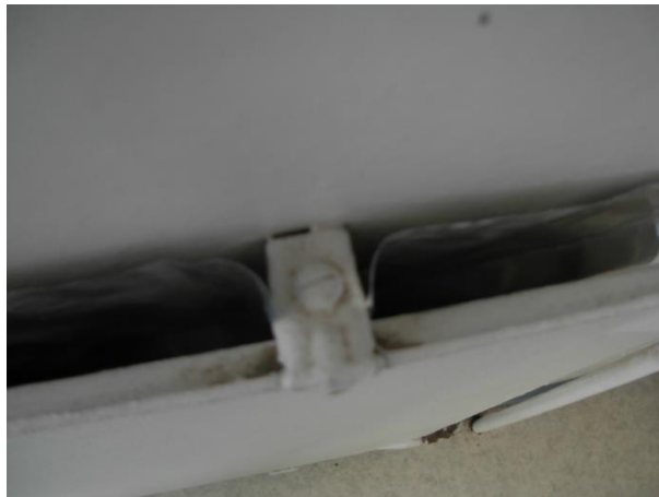
Kuva 4. Lämpöpatterin heijastuskalvon muotoilu.
