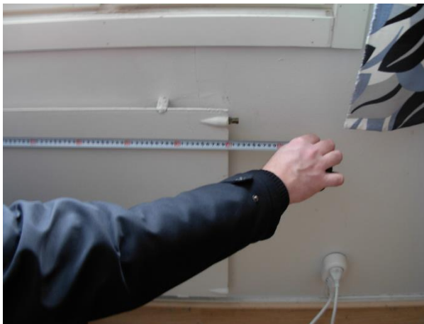
Kuva 2. Lämpöpattereiden leveyden mittaus.
