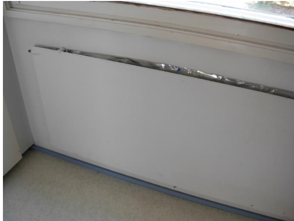
Kuva 3. Lämpöpatterin heijastuskalvon asennus.
