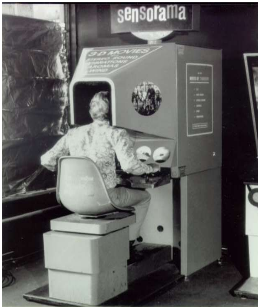
Kuva 3. Sensorama, jossa yhdistyivät stereoskooppiset 3D-kuvat, stereo-ääni, kallistuva istuin, sekä erilliset urat, jotka mahdollistivat myös tuulen ja erilaisten tuoksujen syöttämisen laitteeseen elokuvan aikana [6].
