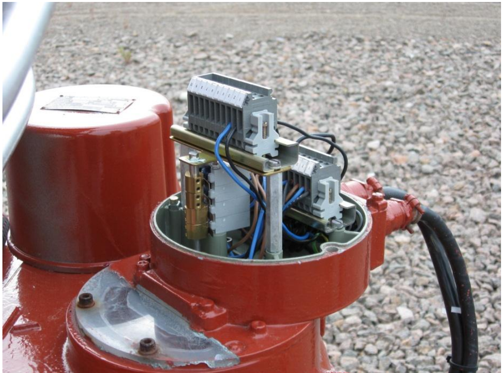
KUVIO 13. Käytössä oleva mekaaninen rajakytkinpaketti
