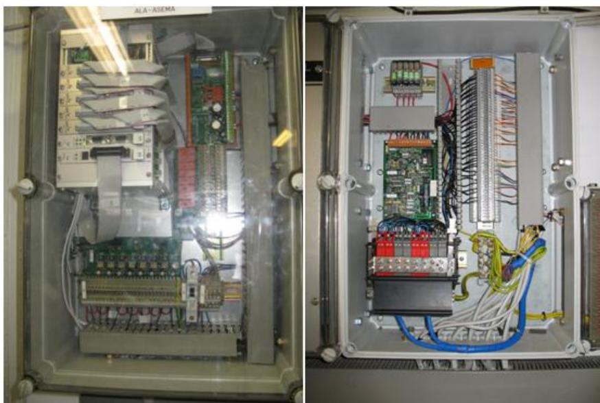
KUVIO 20. Uusi ala-asema ja kytkentäkotelo
