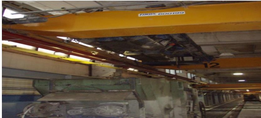
Kuva 5. Valukone vastaanottamassa betonia
