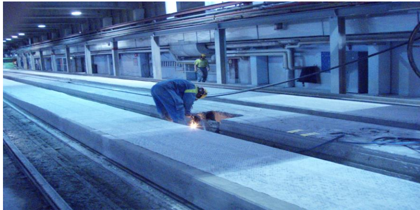
Kuva 20. Elementeissä olevista varauskoloista katkaistaan punokset polttoleikkaamalla
