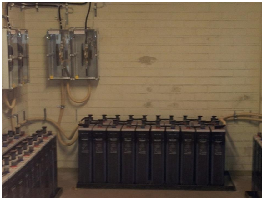
KUVA 11. Voimalaitoksen paikallisakusto (valokuva Juha Heiskanen.)
