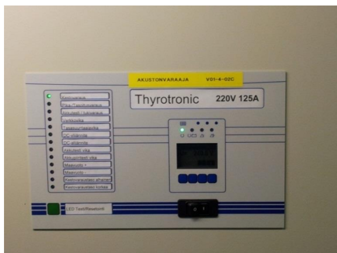
KUVA 12. Akustovaraaja (valokuva Juha Heiskanen.)
