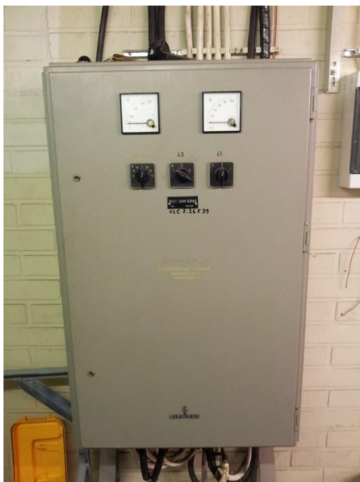
KUVA 5. Varmennetun verkon keskus V01-17 (valokuva Juha Heiskanen.)
