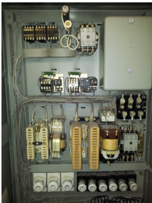
KUVA 6. Keskuksen V01-17 varavoimakoneen ohjauskytkennät (valokuva Juha Heiskanen.)
