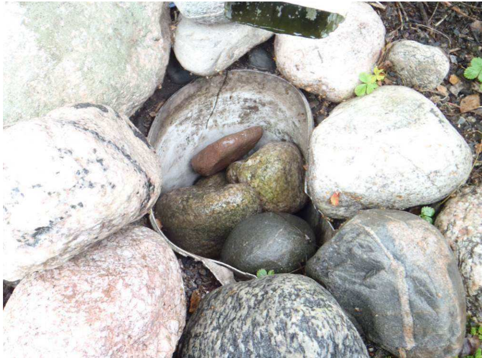
Kuva 11. Sadeveden ohjausta syöksytorven alta
