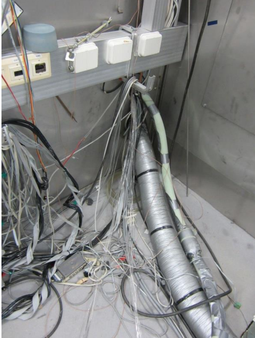
KUVA 14. Seinän läpi viedyt vesiletkut testaushuoneessa
