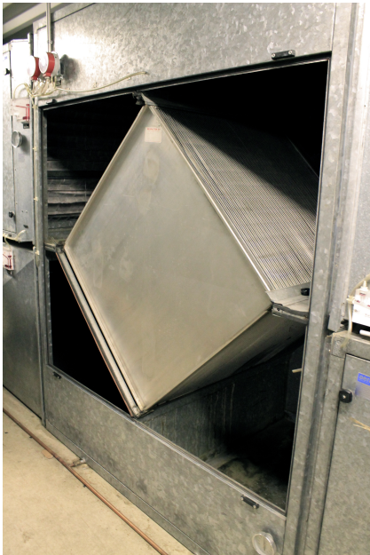
Kuva 3. (Oikea) Levylämmönsiirrin naulakallion koululla. Kuva Elina Järvelä (Vasen) Levylämmönsiirtimen periaate Olli Seppäsen (1996, s.286) esimerkin mukaan
