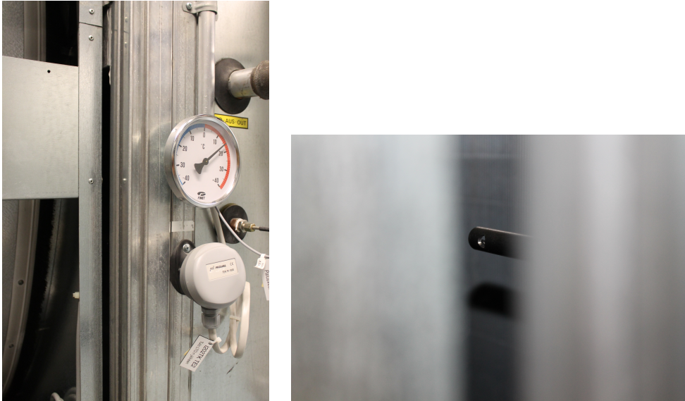
Kuva 15. LTO-laitteen kiinnitys estää kennon ja lämmityspatterin väliseen tilaan pääsemisen. Kuvat Elina Järvelä
