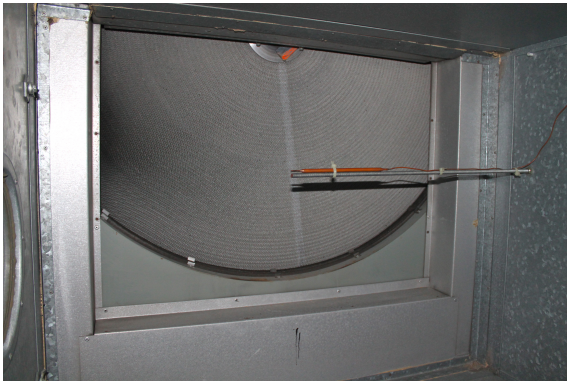
Kuva 17. 10 TK/PK:n LTO-laite
