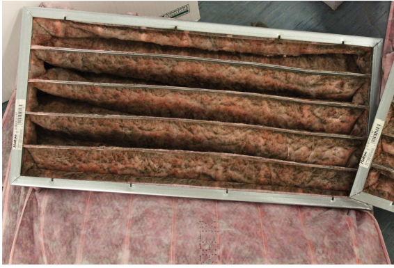
Kuva 21. TK/PK 208 likainen raitisilmasuodatin. Kuva Elina Järvelä
