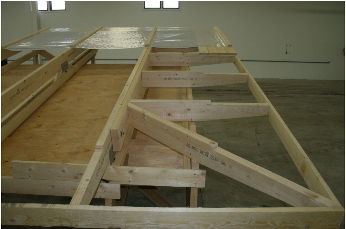
Kuva 8. Päätyräystäselementin kiinnittyminen ristikkoon (Kotasen Puutyö Oy)
