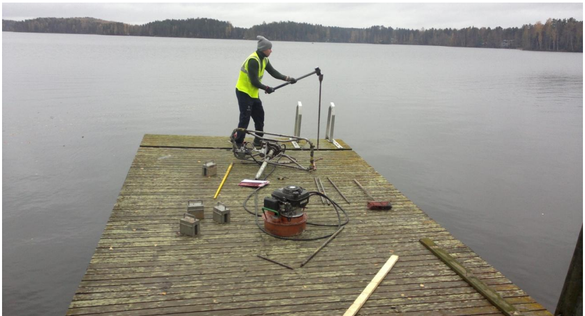
KUVA 7. Painokairauksen lopettaminen lyön-teihin suunniteltavan alueen nykyisen laiturinkannen päältä, pisteessä 2
