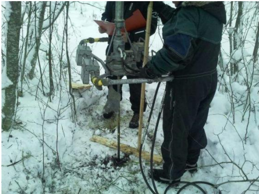
KUVA 6. Käsikäyttöinen painokairalaitteisto, kuvasta puuttuu polttomoottori (Lahti & Lindegren 2012)
