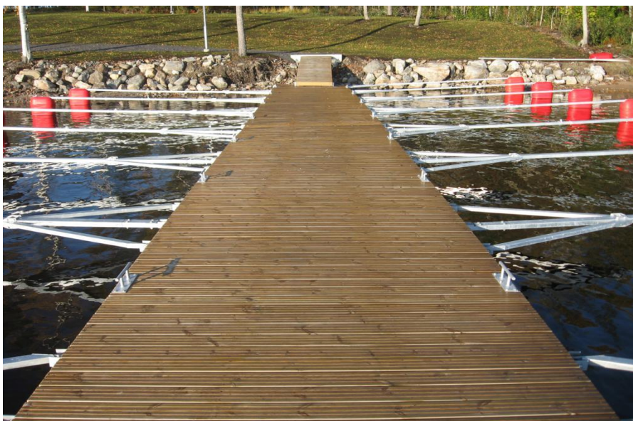
KUVA 31. Esimerkki tarjouspyynnön mukaisesta K-sarjan laiturista, maatuesta sekä kävelysillasta (A-Laiturit Oy)
