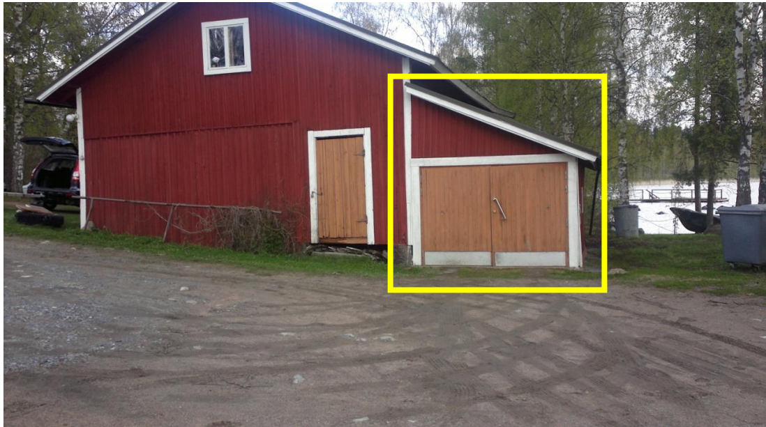
KUVA 42. Purettavaksi suunnitellut rakennukset
