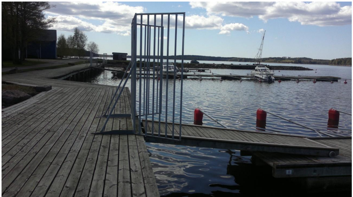
KUVA 14. Esimerkki kiinteästä laiturista, jossa on paalujen päälle rakennettu kiinteä rannansuuntainen laituri ja siitä merelle päin lähtevät kelluvat elementit puomeineen
