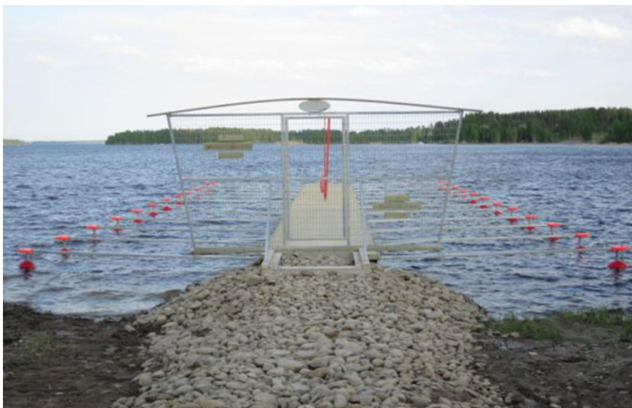
KUVA 33. K-sarjan laituri sekä ulkopuolisten pääsyä rajoittava portti (A-Laiturit Oy)
