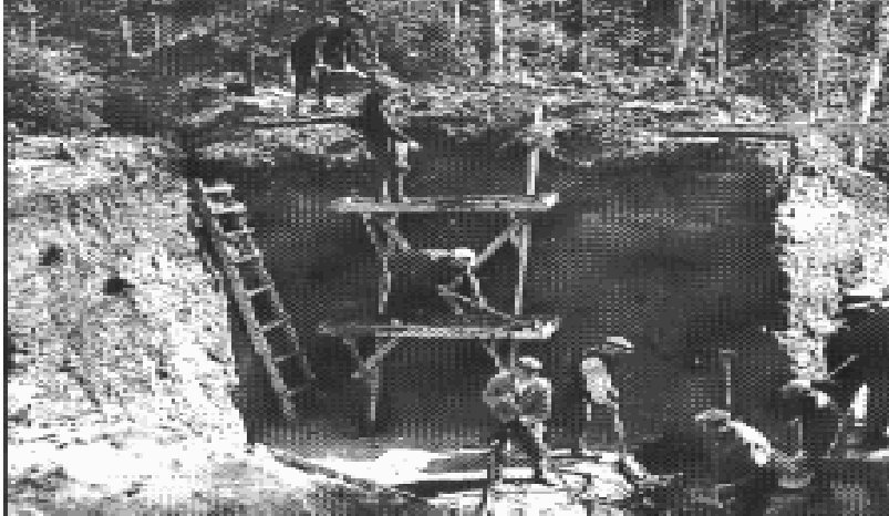
Kuva 7: Korsunpohjan kaivua, (internet- kuvahaku)
