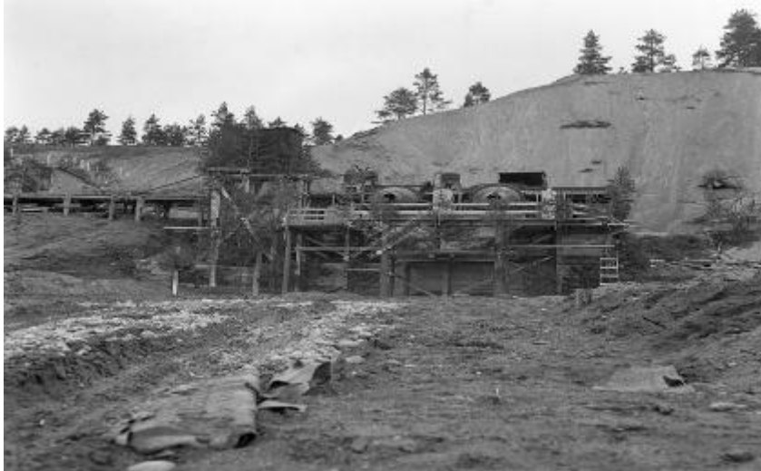
Kuva 9: Betoniasema, (SA- kuva)
