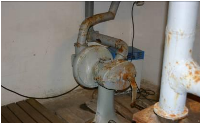
Kuva 11: Ilmanvaihtoa varten asennettu veivattava pumppu, Salpamuseo Miehikkälä, Kaikkonen 2011
