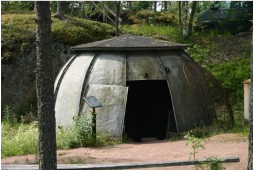
Kuva 19: Pallokorsun peltinen ulkomuotti, Salpamuseo Miehikkälä, Kaikkonen 2011
