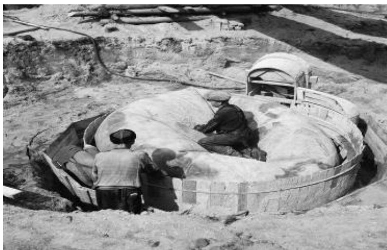
Kuva 16: Juurimuotin ja sisäpallon asennus, (SA- kuva)
