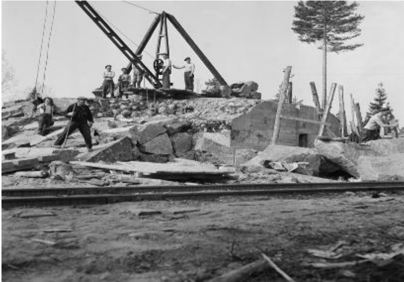
Kuva 10: Kivisuojausten asennusta korsun ympärille, (SA-kuva)
