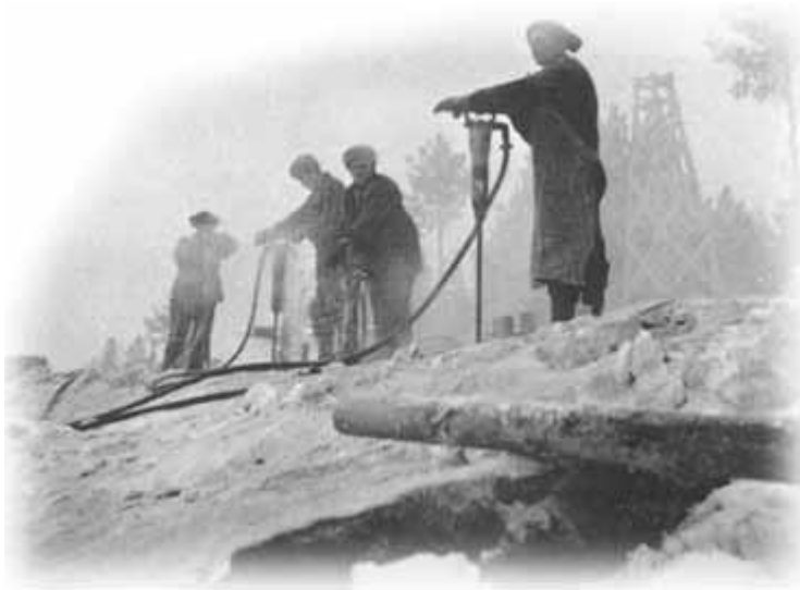
Kuva 27: Panssariestekivien poraus käynnissä, (SA-kuva)
