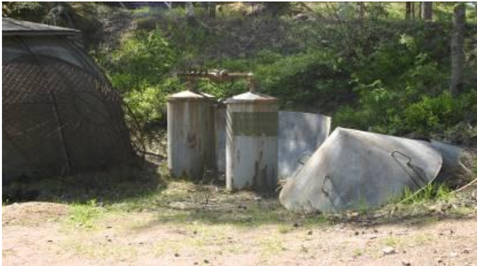
Kuva 20: Muottikalustoa, imubetonoinnin painesäiliöt, Miehikkälä, Kaikkonen 2011
