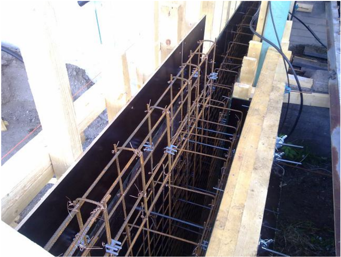
Kuva 3. Seinäraudoitus kuvattuna ylhäältä päin kohti muottia. [15]
