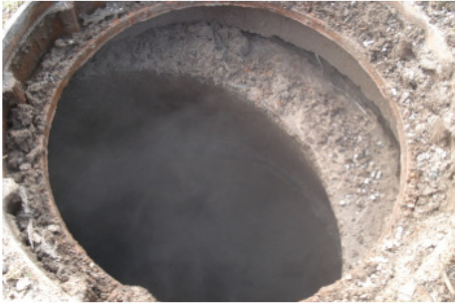
Kuva 9. Tarkastuskaivon korokerenkaan sivuttaissiirtymä
