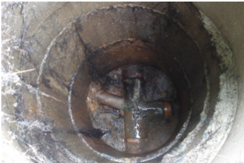
Kuva 10. Huonokuntoinen betonitarkastuskaivo
