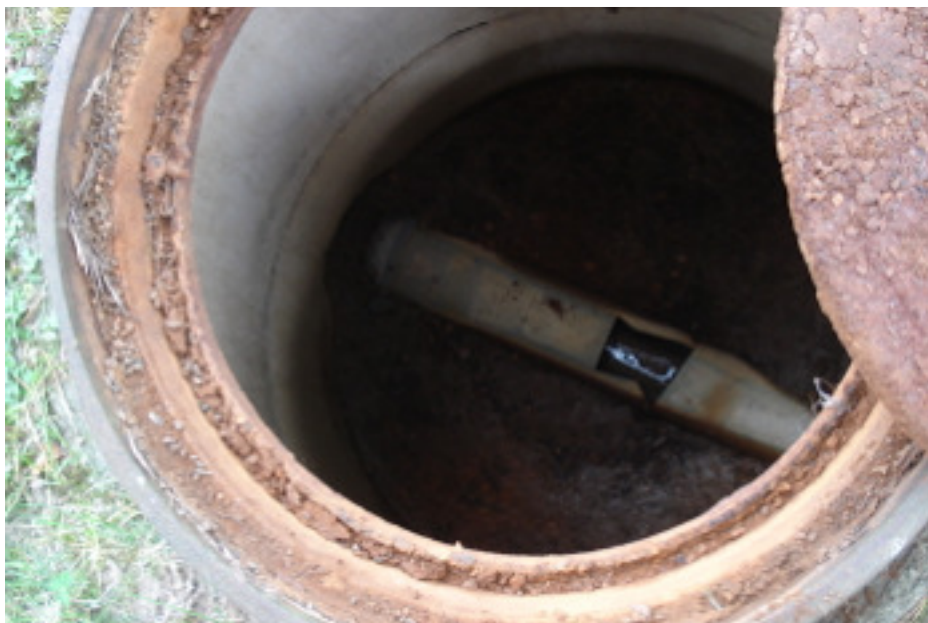
Kuva 6. Avarrettu viemäriputki tonttikaivossa
