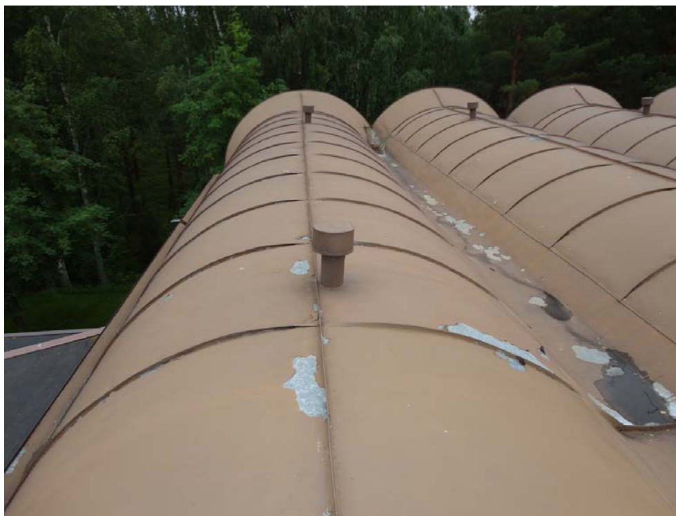
Kuva 4. Juhlasalin peltikatteen nykytilanne (Valokuva Halsas 2012.)
