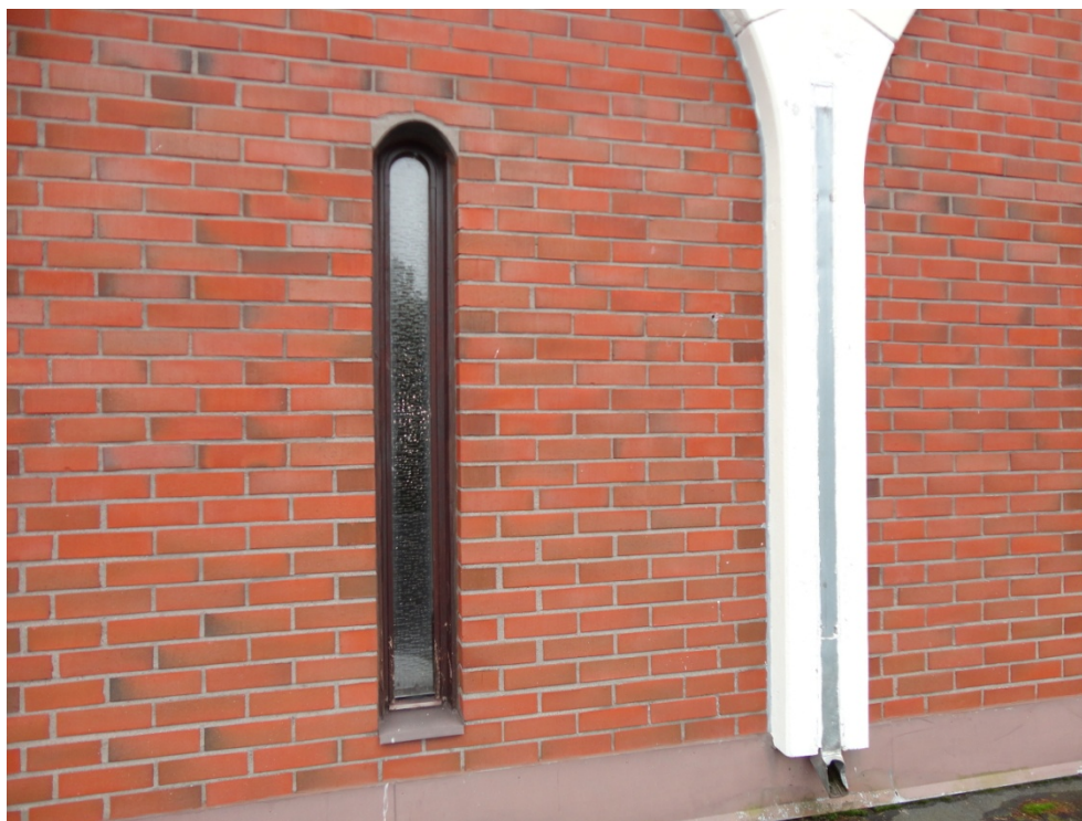
Kuva 10. Betoniin upotettu syöksytorvi (Valokuva Halsas 2012.)
