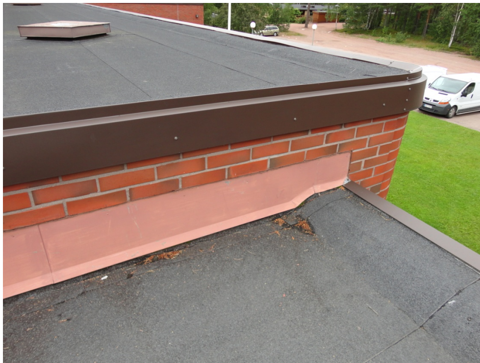
Kuva 5. Olemassaoleva räystäsmuoto sekä rintapelistystä (Valokuva Halsas 2012.)
