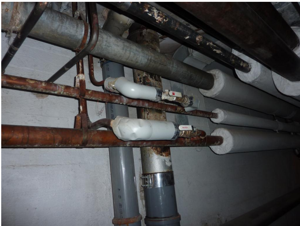
Kuva 2. Vanhoja vesijohtoja ja osittain vaihdettuja viemäriputkia kellarissa (Kuvannut: Aleks Salminen).
