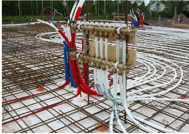
Kuva 6. Vesikiertoinen lattialämmityksen jakotukki asennettuna ennen betoni valua. (Ouman Oy 2013. Kuvapankki. Sisäinen Intranet, hakupäivä 17.7.2013)
