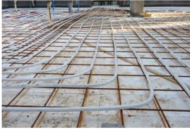
Kuva 5. Vesikiertoinen lattialämmityspotkisto asennettuna ennen betonivalua (Ouman Oy 2013. Kuvapankki. Sisäinen Intranet, hakupäivä 17.7.2013)
