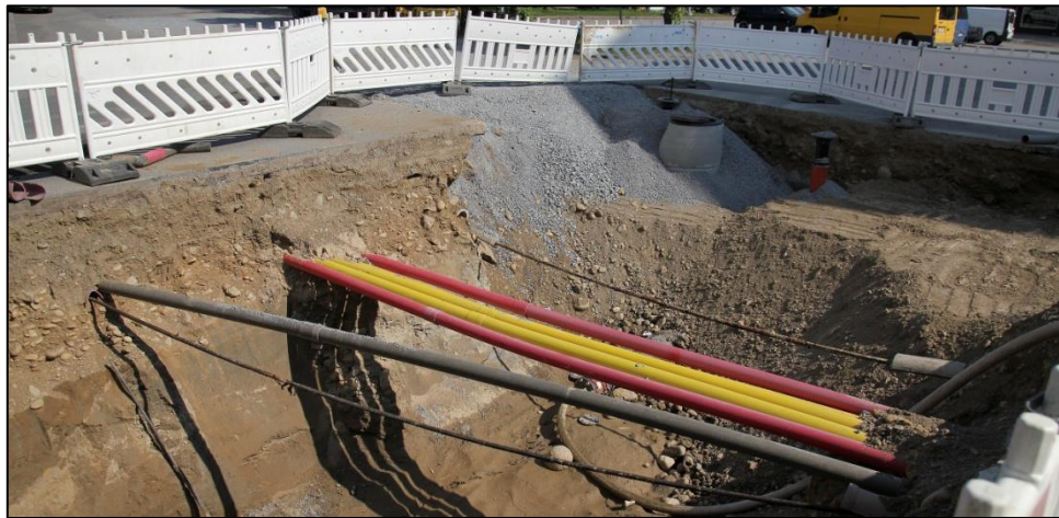
Kuva 28. Kadun ja vesijohtoverkoston saneerausta (valokuva Kirsi Lehtonen).
