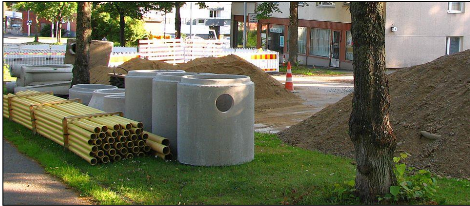
Kuva 8. Materiaalien ja ylijäämämaan varastointia työmaan yhteydessä (valokuva Kirsi Lehtonen).
