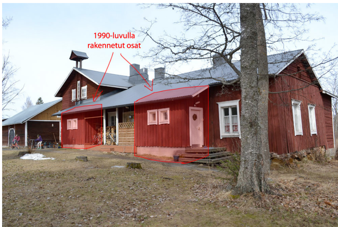
Kuva 1. Possakkatuvan korjattava yksikerroksinen osa (Timo Dunkel 2012)
