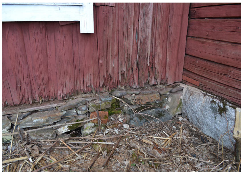
Kuva 6. Julkisivu ja perustus (Timo Dunkel 2012)
