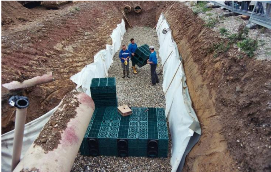
KUVA 67 Saksassa olevan Freiburgin kaupungin Vaubanin alueen hulevesijärjestelmän asennusta. Kuva Roland Veithin esityksestä Stadt Freiburg Projektgruppe Vauban. Esitetty Uudenmaan liiton suunnittelijaryhmälle 23.5.2007.
