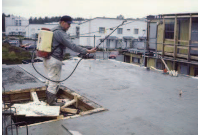
Kuva 3. Varhaisjälkihoitoaineen levitystä suihkuttamalla. (Kuva: Suomen Betonilattiayhdistys ry.)
