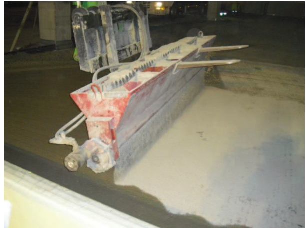
Kuva 6. Kuivasirotteen levitystä erillisellä annostelulaitteella. Laite kiinnitetty kurottajaan. (Kuva: Raul Korolainen 2013.)
