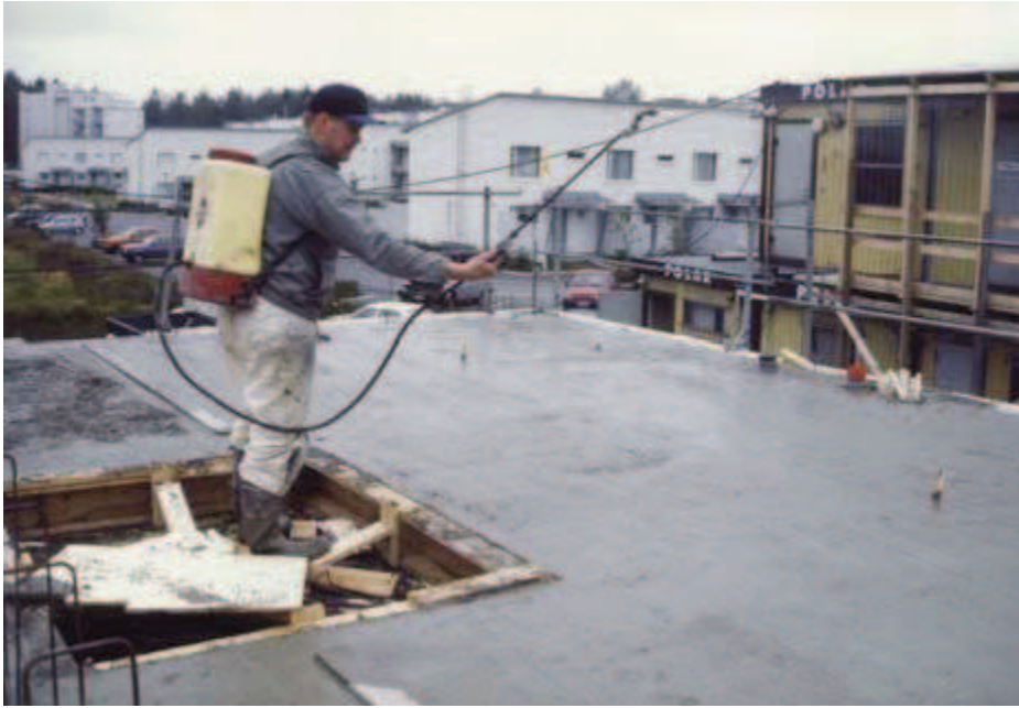
Kuva 14. Varhaisjälkihoitoaineen levitystä tuoreelle betonipinnalle.
