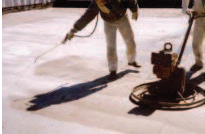
Kuva 4. Betonipinnan levyhierto ja varhaisjälkihoitoaineen levitys samanaikaisesti. (Kuva: Rudus Oy.)
