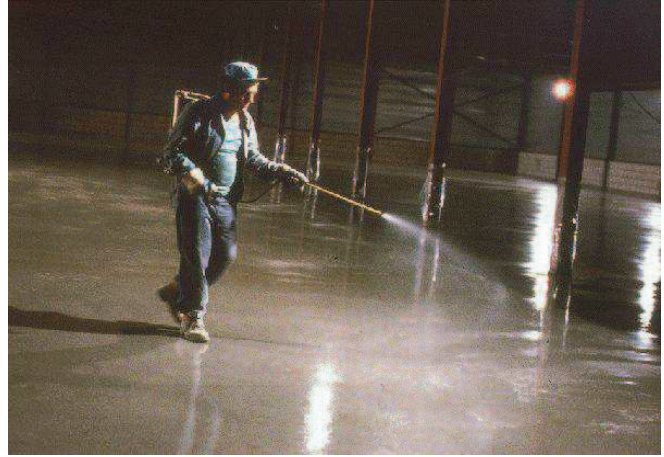
Kuva 12. Jälkihoitoaineen sumuttamista moottorisoidulla reppuruiskulla. (Kuva: Semtu Oy.)
