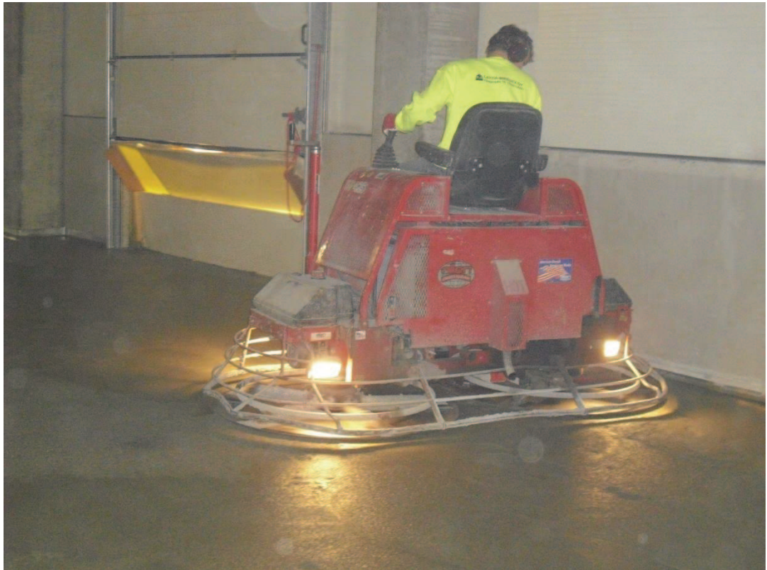
Kuva 12. Päältäajettava levyhiertokone. (Kuva: Raul Korolainen 2013.)
