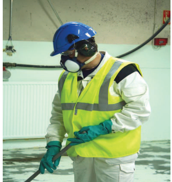
Kuva 14. Suojavarustus. (Kuva: Lattian pinnoituksen työturvallisuusopas 2009.)
