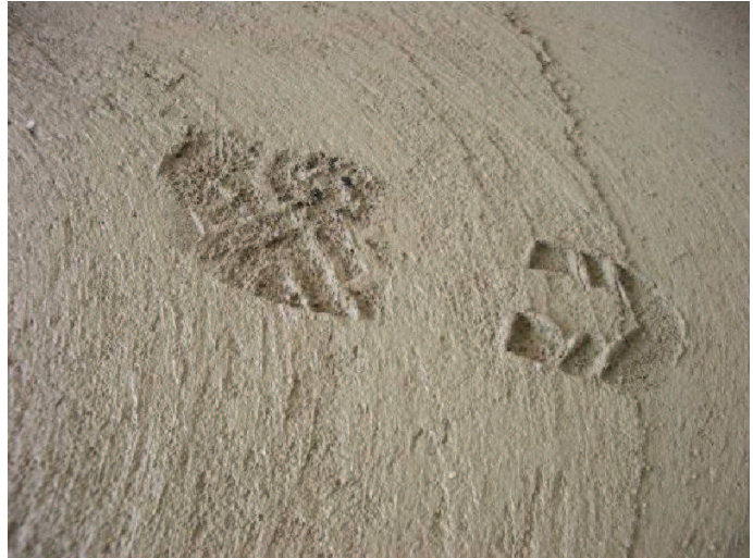
Kuva 5. Betonipinnan hierto aloitetaan, kun pintaan jää kävellessä noin 5 mm syvyinen kengänjälki. (Kuva: Korodur.de.)
