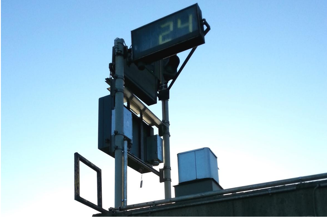
KUVA 31. Muokattu näyttökotelo, jälkiasennetut kanavasuoittimet
