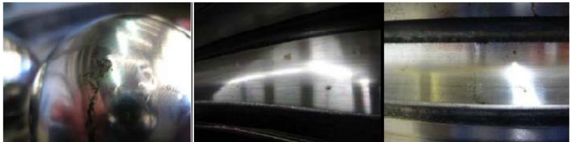
Kuva 23. Ohjausyksikön laakerin kulumajälkiä (ABB Extend Maintenance Intervals 2011)
