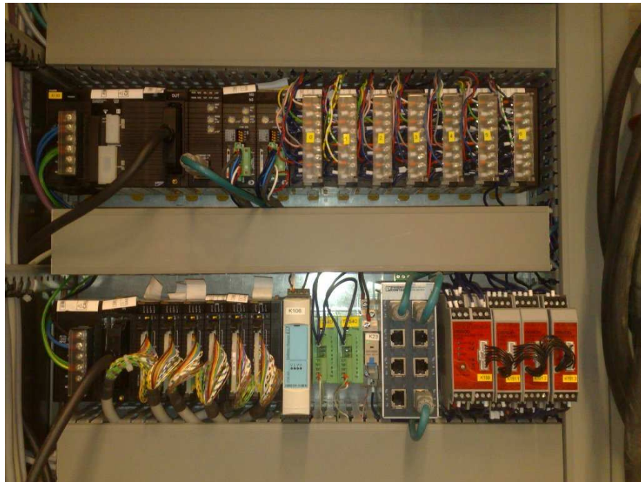
KUVA 10 Täyttöyksikön logiikan keskusyksikkö
