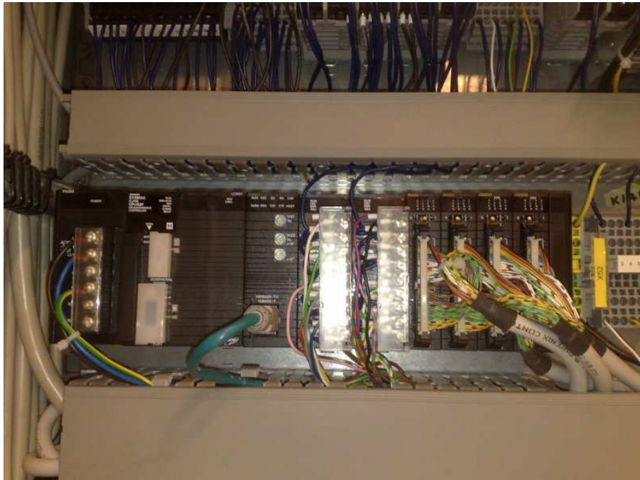
KUVA 6 Purkinmuodostusyksikön logiikan keskusyksikkö
