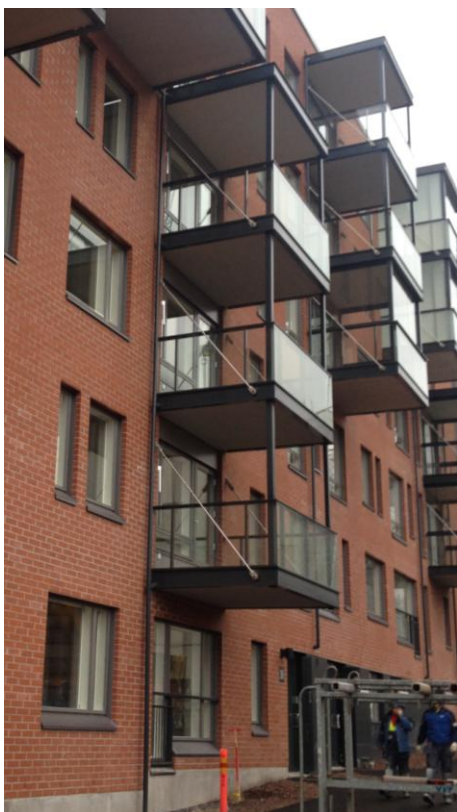
Kuva 18. Vetotangoilla ripustetut teräsbetoniparvekkeet valmiina.
