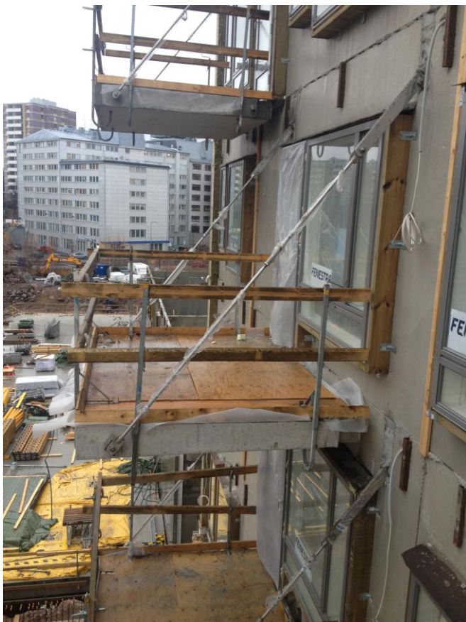
Kuva 18. Runkovaiheessa asennettu parveke Helsingin Bliksti -työmaalla.
