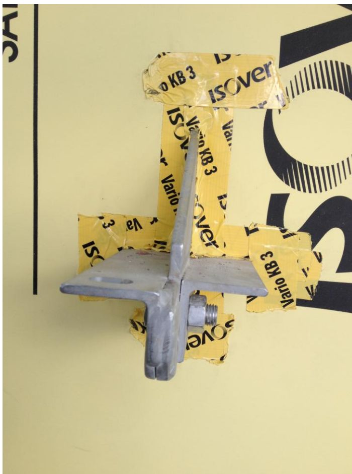
Kuva 10. Parvekekiinnikkeen vierustan tiivistäminen.
