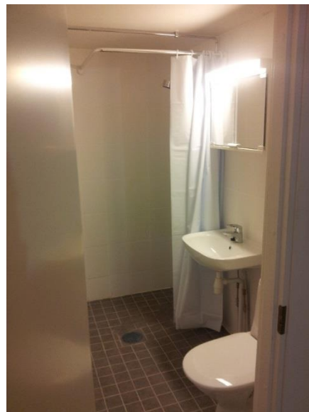
Kuva 14. Valmis kylpyhuone kalusteineen.
