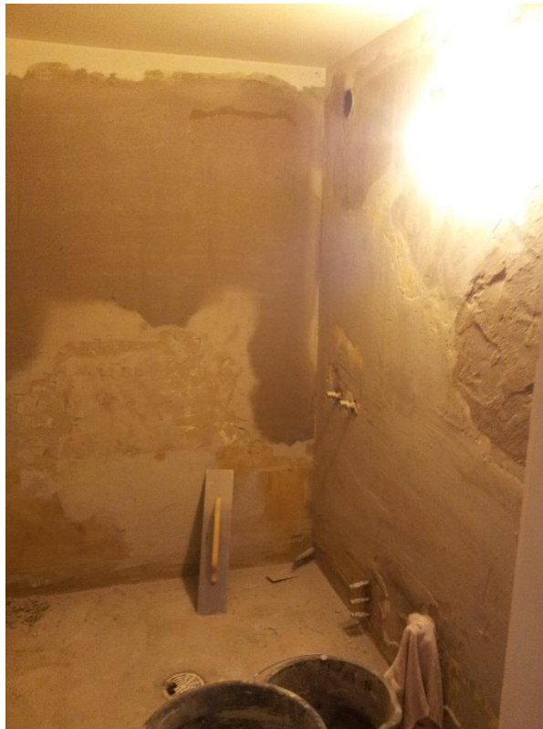
Kuva 10. Kylpyhuone purettuna ja tasoitetyö aloitettuna.
