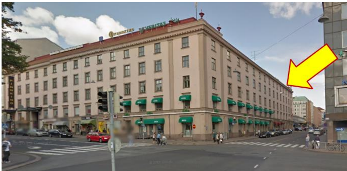
Kuva 2. Kiinteistön fasadi. Nuoli osoittaa perusparannettavan huoneiston sijainnin. (Google maps 2013.)
