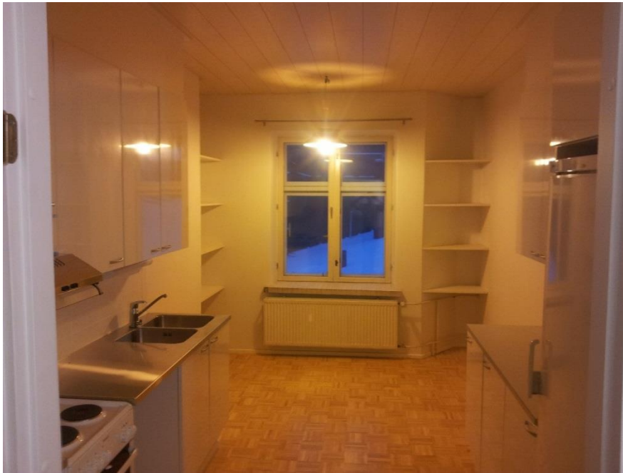
Kuva 11. Valmiita pintoja. Lattia hiottuna, katto uusittuna sekä keittiön uudet kalusteet.
