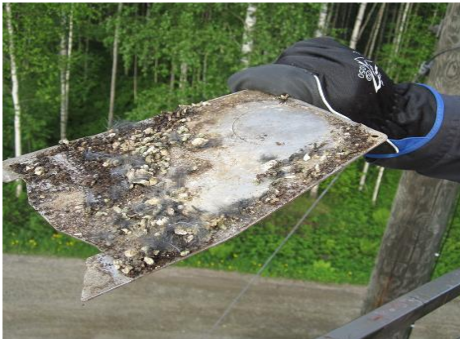
KUVA 12. Keskustien valaisimen pohjalevy, (valokuva Anssi Kuittinen.)
