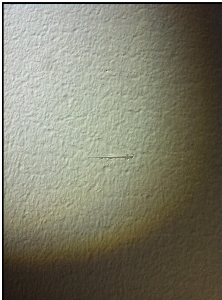
Kuva 7. Kolhu seinämaalauksessa. Kolhun erottuu vinottaisessa valossa, kuten ikkunasta tulevassa valossa.
