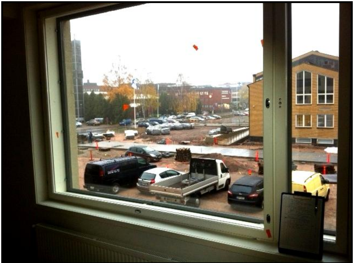
Kuva 6. Teippaukset auttavat virhekohtien huomaamista tarkastuskohteessa.
