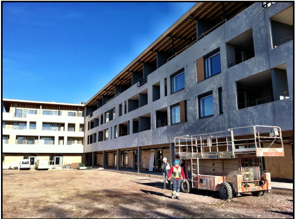
Kuva 1. As Oy Tikkurilanaukio kaupungin torin puolelta.
