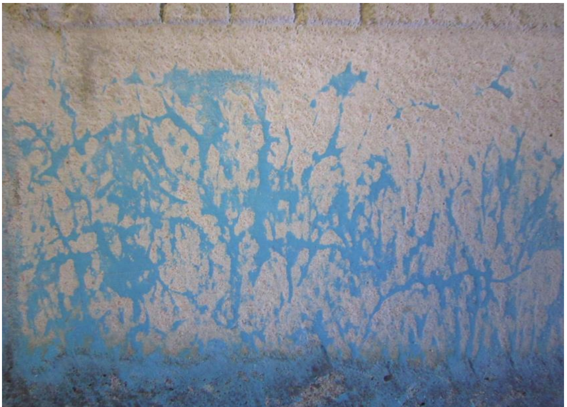
Kuva 37. Yleiskuvaa kokeen järjestelystä, osakorjausmallit. Valmis huonosti puhdistettu pinta. Tekstuuri on telattu pinta.
