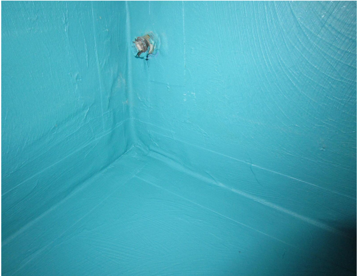
Kuva 2. Märkätilan nurkka ja läpivienti.
