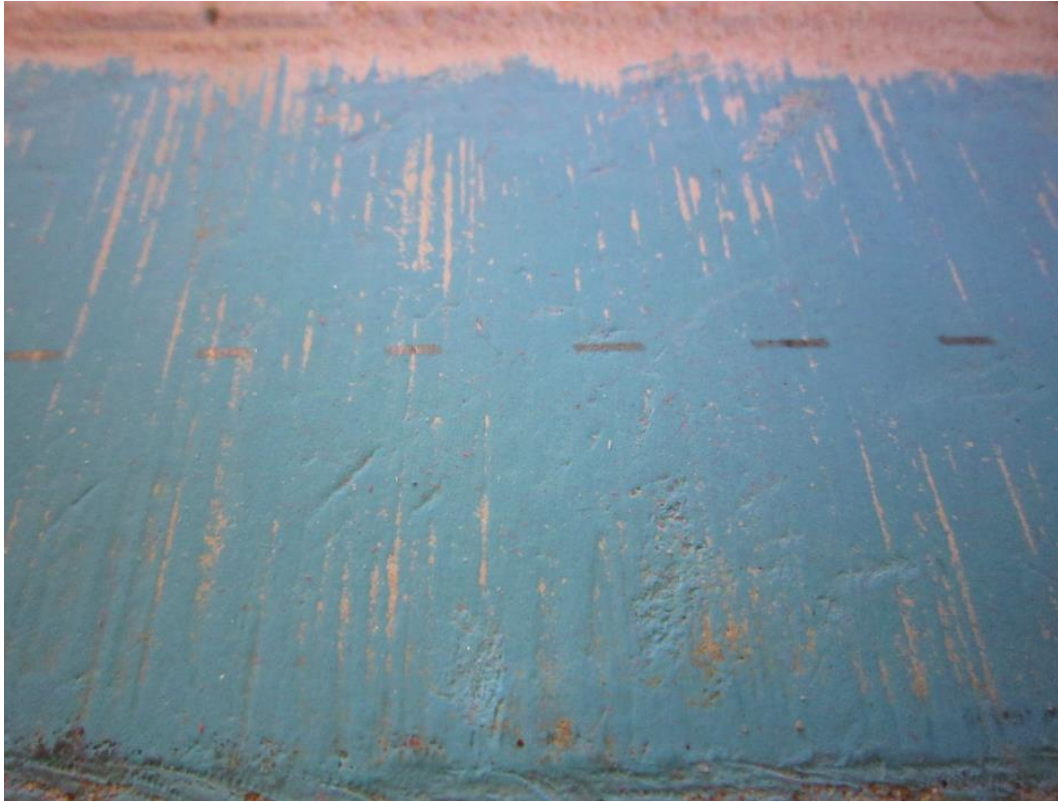
Kuva 32. Yleiskuvaa kokeen järjestelystä, osakorjausmallit. Valmis hyvin puhdistettu pinta, teksturi on sivelemällä tasoitettu.
