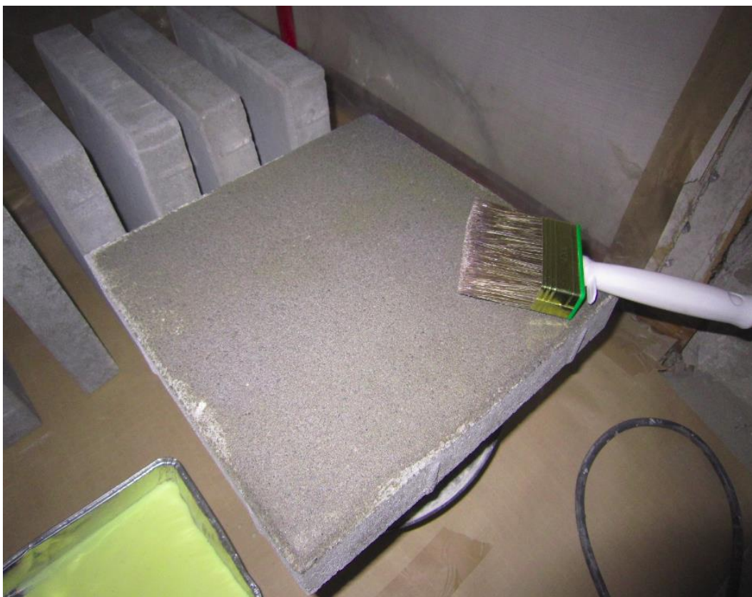
Kuva 1. Yleiskuvaa kokeen järjestelystä. Mallikappaleen betonilaatan tartuntapohjustuskäsittely.
