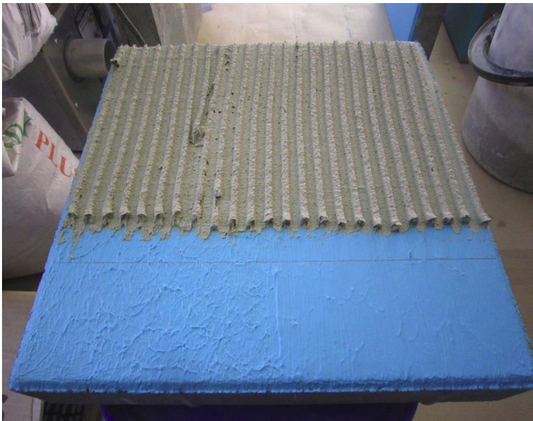
Kuva 4. Yleiskuvaa kokeen järjestelystä. Vedeneristetyn mallikappaleen laatoitustyö on käynnissä.
