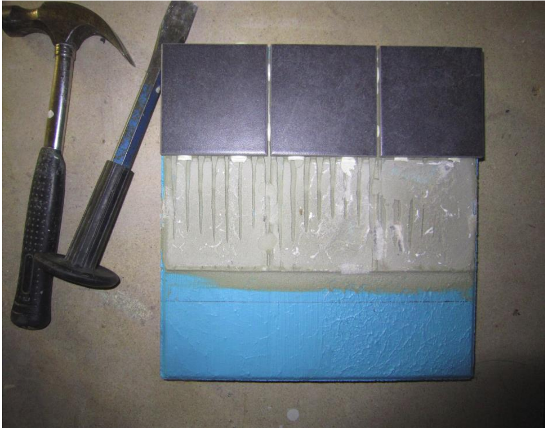
Kuva 26. Yleiskuvaa kokeen järjestelystä, osakorjausmallit. Purettu laatoitus. Työkaluja.
