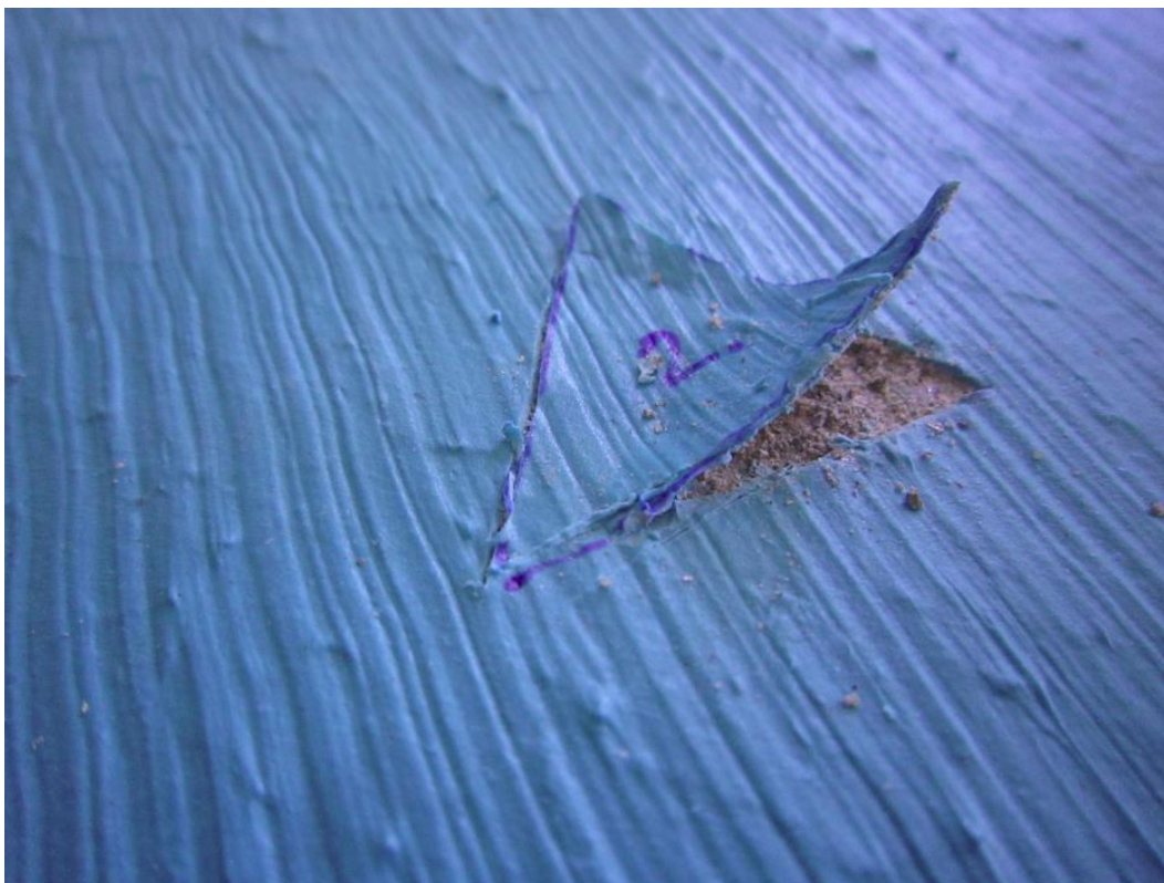
Kuva 7. Yleiskuvaa kokeen järjestelystä. Vedeneristyksen valvontatyössä leikattavan aukon leikkaaminen.
