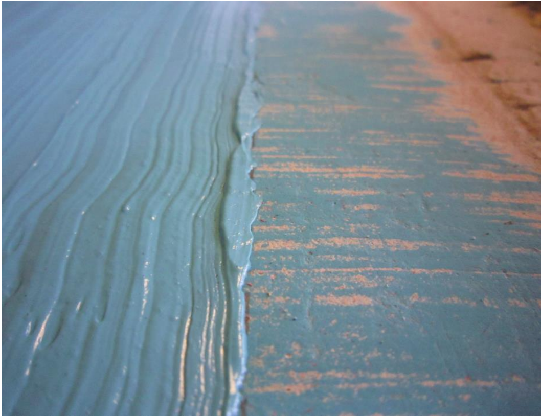
Kuva 34. Yleiskuvaa kokeen järjestelystä, osakorjausmallit. Vanhan ja uuden vedeneristeen limityskohta.
