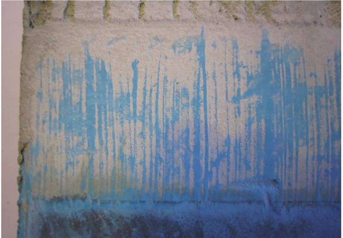
Kuva 36. Yleiskuvaa kokeen järjestelystä, osakorjausmallit. Valmis huonosti puhdistettu pinta. Tekstuuri on sivelemällä tasoitettu.
