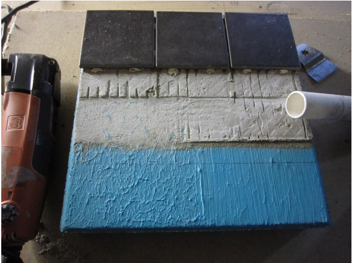
Kuva 16. Laastikerroksen hiominen laatoituksen purkamisen jälkeen.
