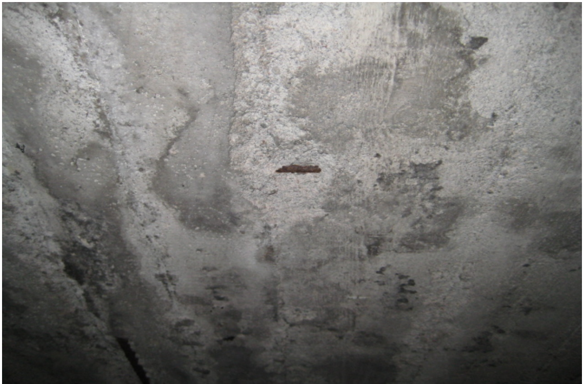
KUVA 4. Kellarin välipohjan alapinnan teräkset.
