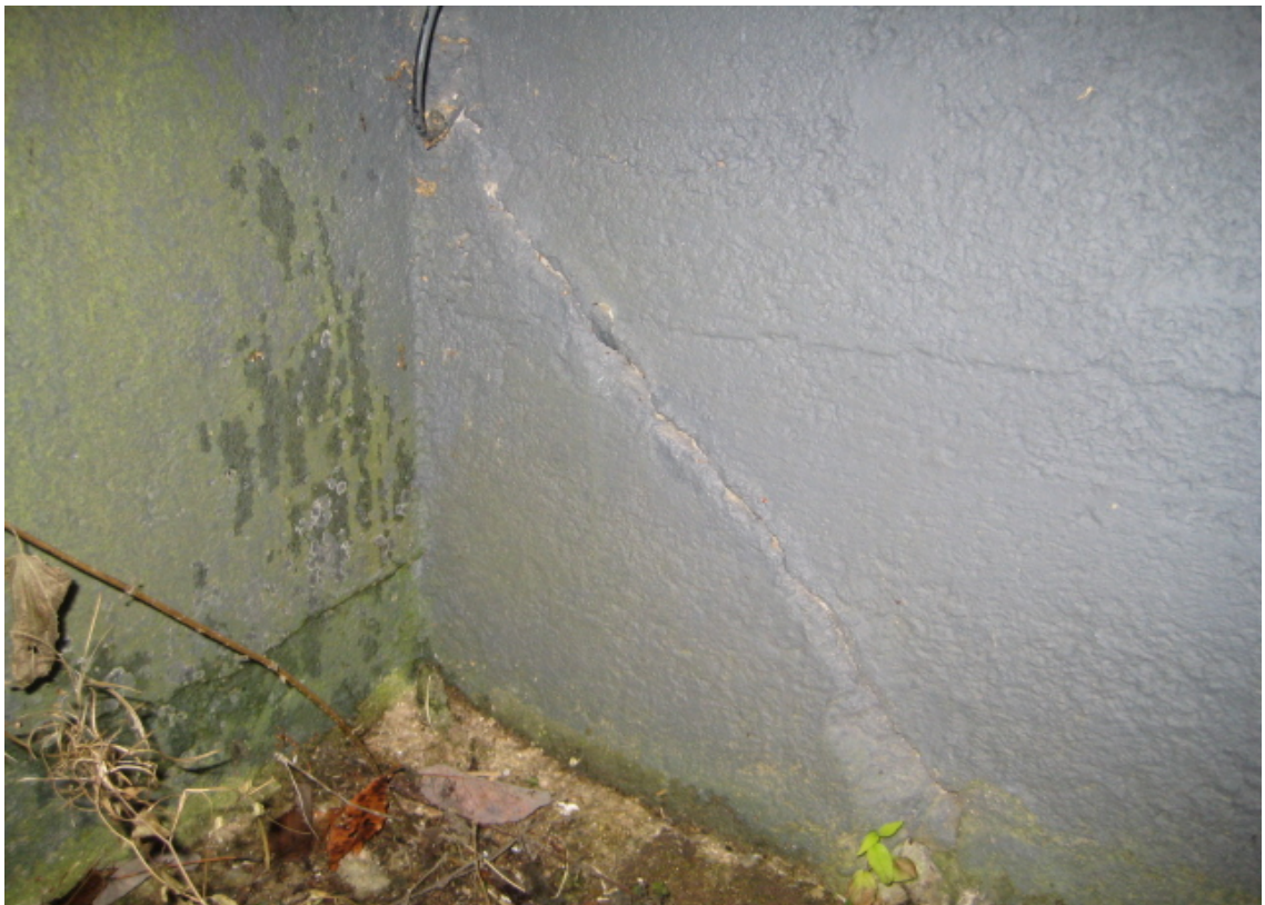
KUVA 2. Halkeama ja kasvillisuutta sokkelissa.
