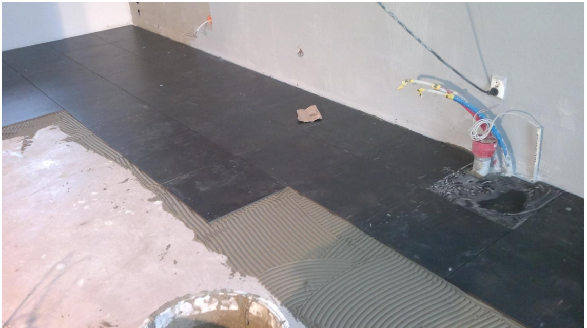
kuva 5: Makkarakammalla levitettyä laastia.
