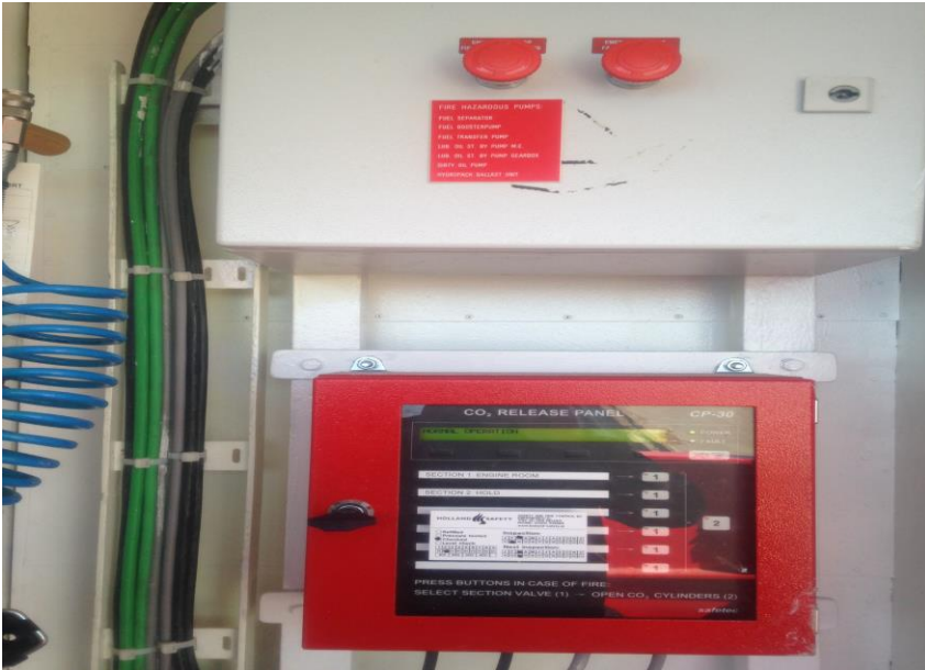
Kuva 11. Kuva Panta Rhei hiilidioksidi sammutusjärjestelmän laukaisukeskus (Petri Pätilä).
