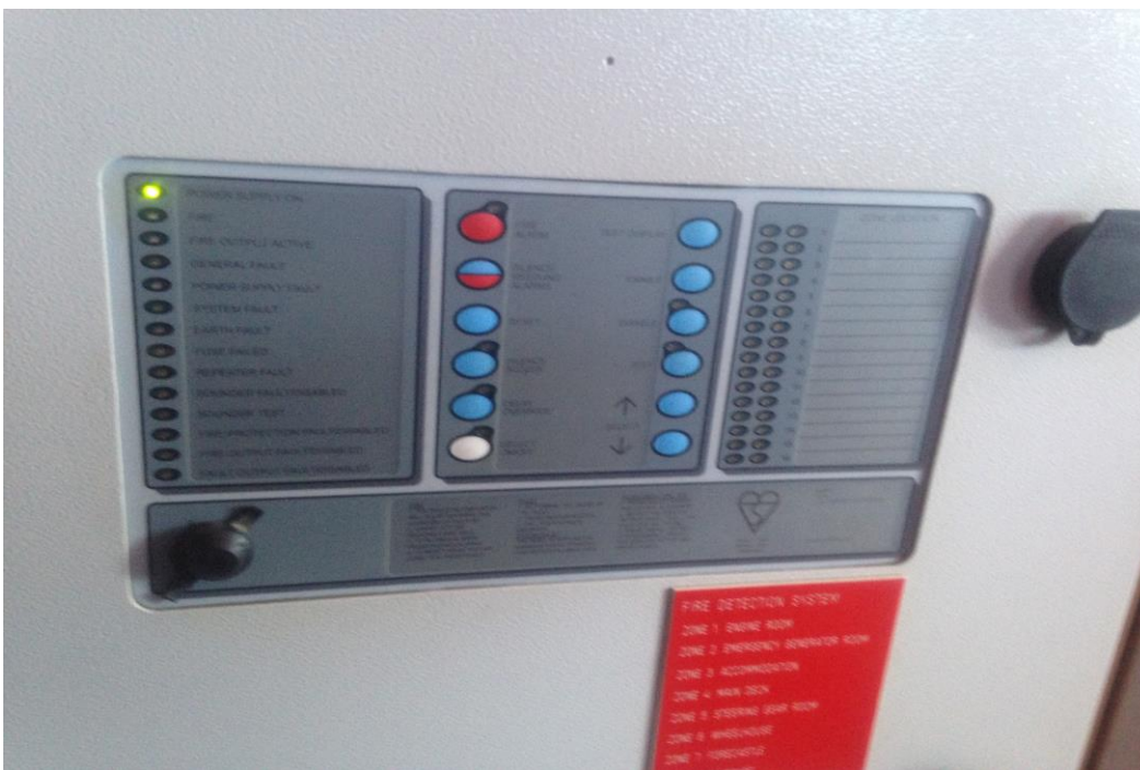
Kuva 10. Kuva Panta Rhein paloilmoitinpaneeli komentosillalla (Petri Pätilä).
