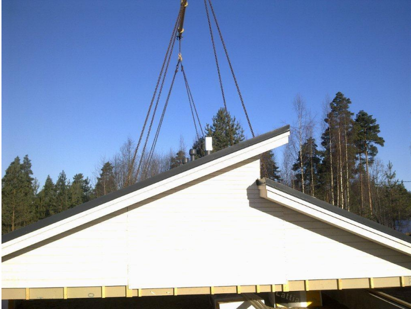
KUVA 9. Esimerkki kattoelementin nostosta nostopalkilla
