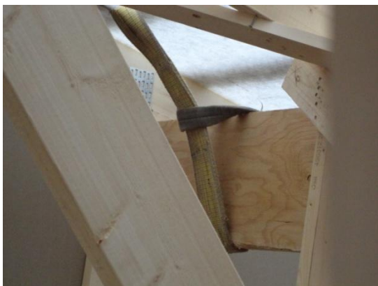
KUVA 13. Nostovyön kiinnitys nostoapupalkkiin
