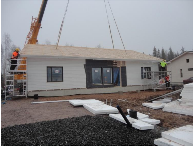
KUVA 15. Kattoelementin paikalleen asentaminen Ritaharjussa
