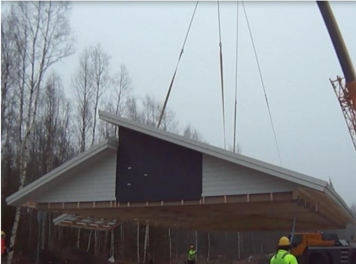
KUVA14. Ohjausliinojen käyttö kattoelementin asennuksessa
