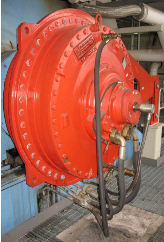
Kuva 3.2 Marathon MB-800-nestemoottori käyttää DD-pesuria
