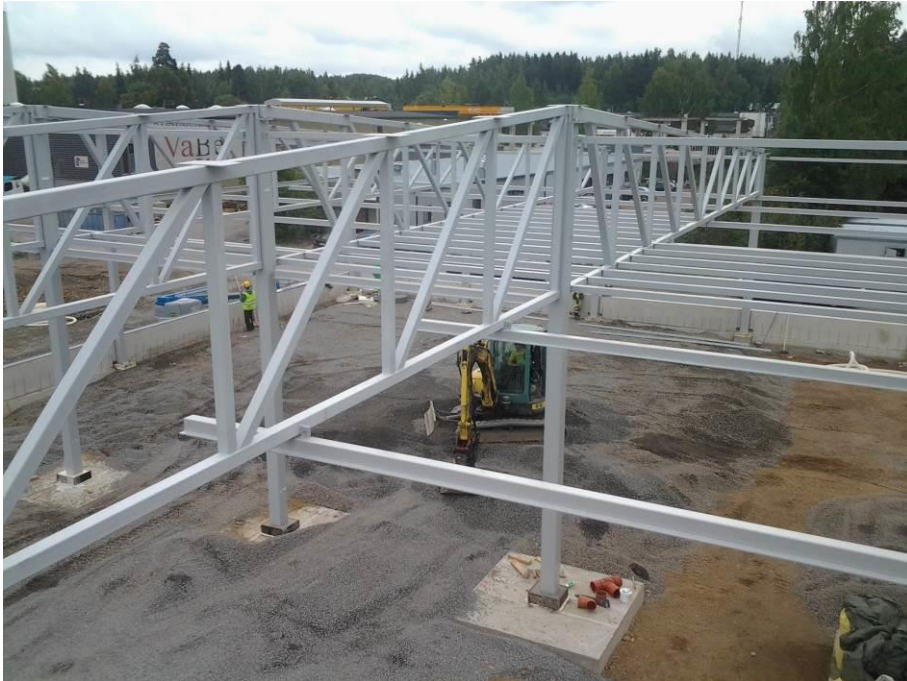
KUVA 3. Teräsrungon asennus on valmis, maanvaraisen lattian täyttö ja pilareiden pulttiryhmiä juotosvalut ovat meneillään.
