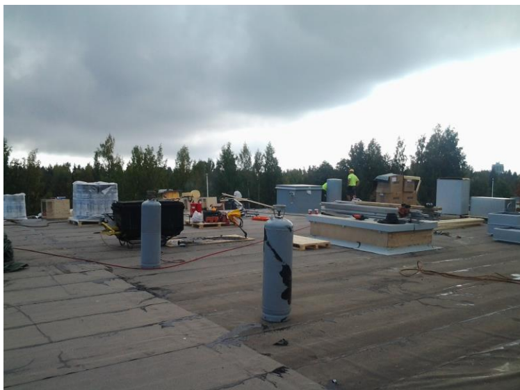
KUVA 14. Pohjahuopa on liimattu vesitiiviiksi ja materiaalit ja kalusto on nosteltu katolle.
