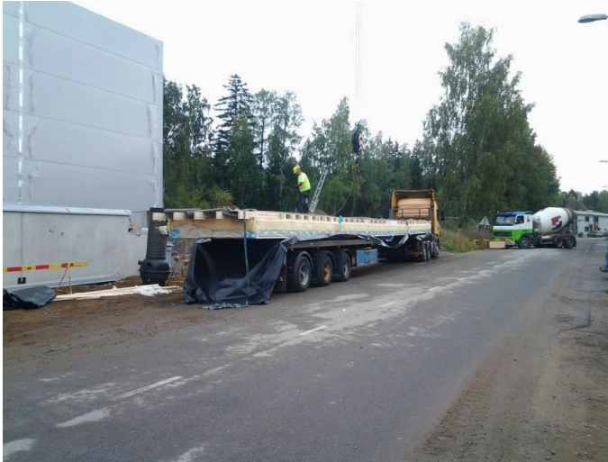
KUVA 7. Kattoelementti nostetaan suoraan ajoneuvosta paikoilleen.
