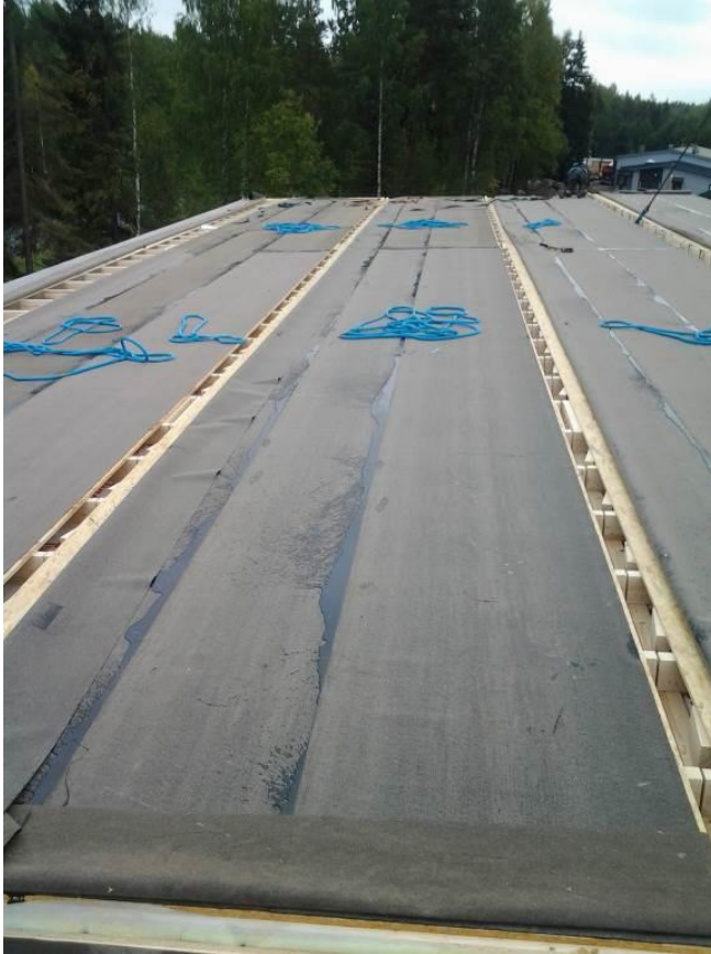
KUVA 9. Elementit paikalleen asennettuina, saumalaudoitus puuttuu.
