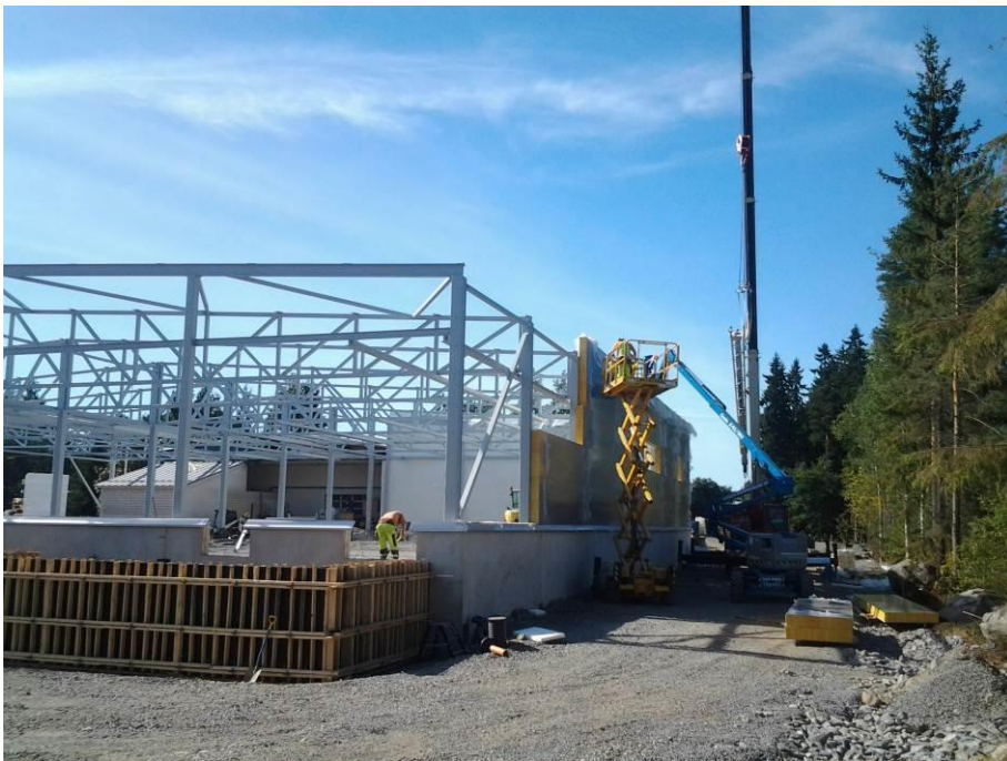
KUVA 4. Teräsrunko on asennettu ja meneillään on julkisivuelementtien asennus
