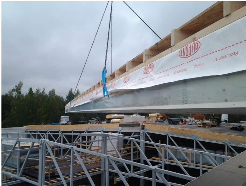
KUVA 5. Kulkusillat ovat valmiit ja ilmanvaihtokoneet ja jäädytysvesiasema on nostettuna yläpohjaan.
