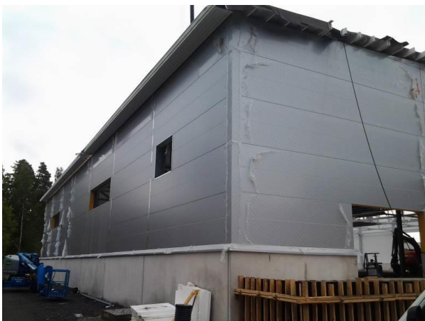
KUVA 8. Pitkän sivun räystääs on elementtisauman laudoituksia vaille valmis.
