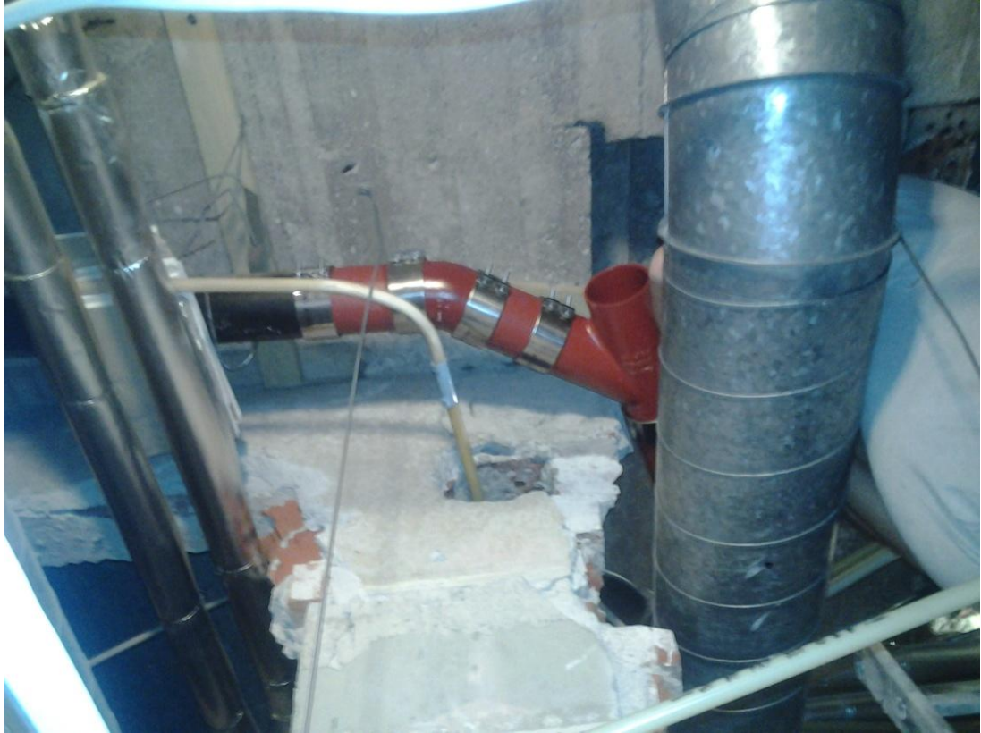
Kuva 11. Viemäritöitä alakerran välikatossa.
