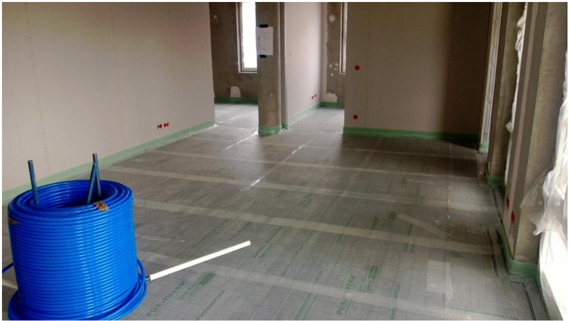
Kuva 15. Lattialämmitysputkiston asennustyö
