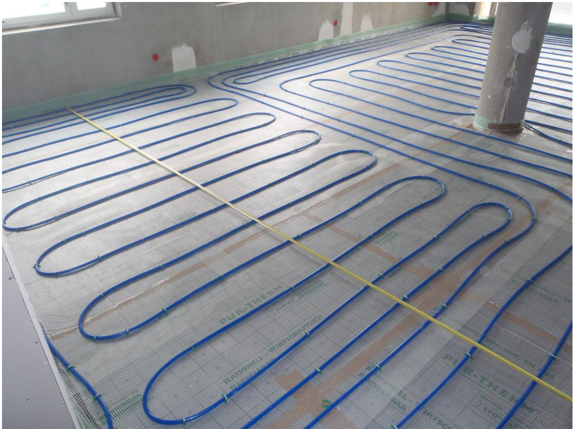
Kuva 10. Lattialämmitysputkisto ennen lattiatasoitteen pumppausta
