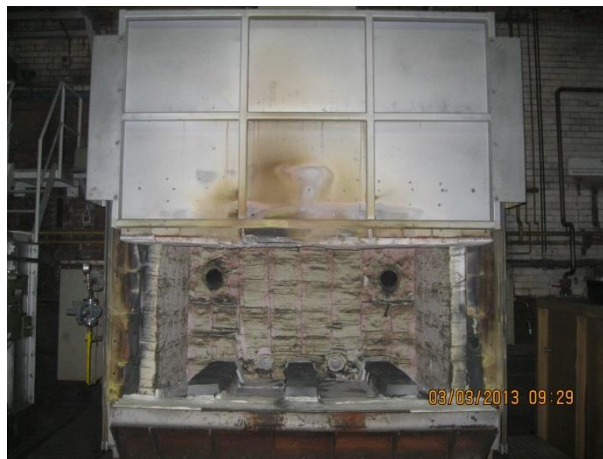
Kuva 4. Pieni 2 -lämpökäsittelyuuni Sulzer Karhulan valimo
