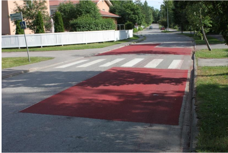
Kuva 27. Työmiehenkuja – Torpantie massan levityksen jälkeen
