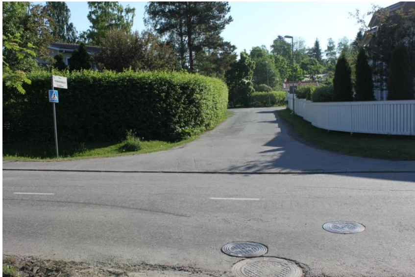
Kuva 19. Työmiehenkuja on etuajo-oikeutettu
