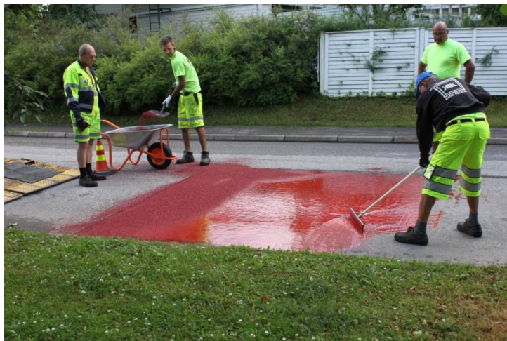
Kuva 26. Massan ja kiviaineksen levitys.
