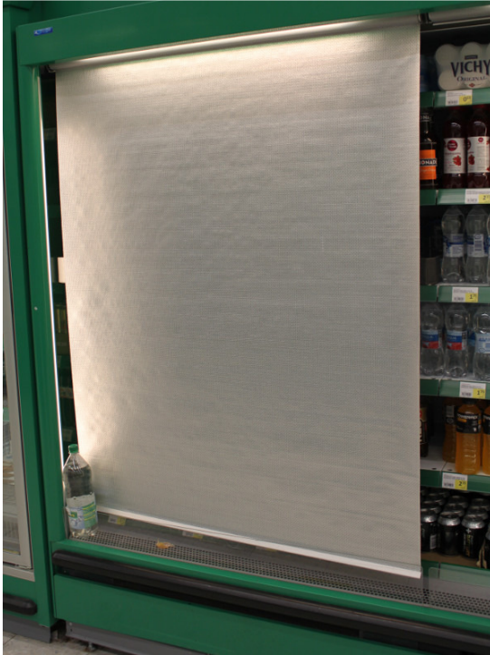
Kuva 3. Kylmähyllyn verho, joka vedetään yöksi hyllyn eteen vähentämään jäädytyksen energiankulutusta.
