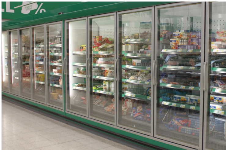
Kuva 2. Pakastekaappi, jossa on itsestään sulkeutuvat ovet.
