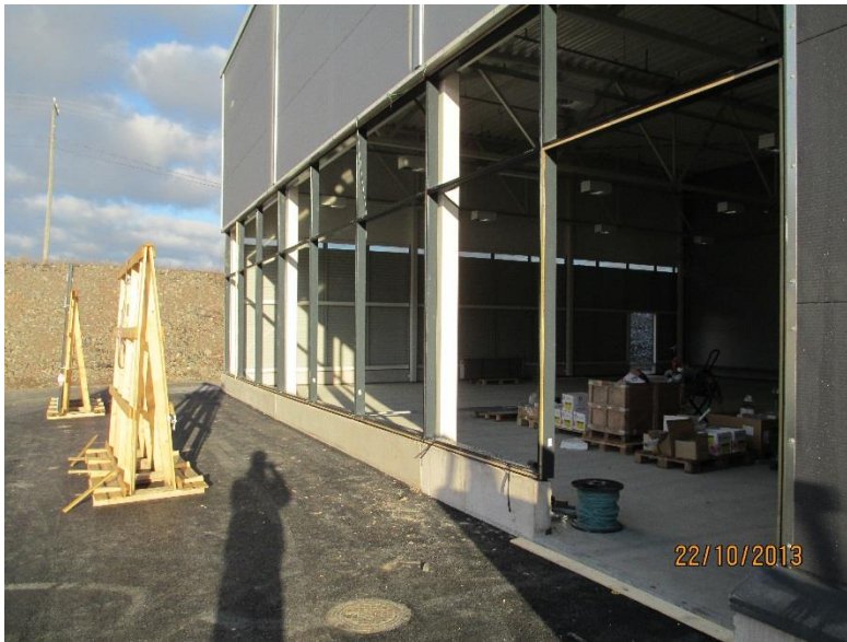
Kuva 12. Ulkolasisseinän runkoa asennettuna
