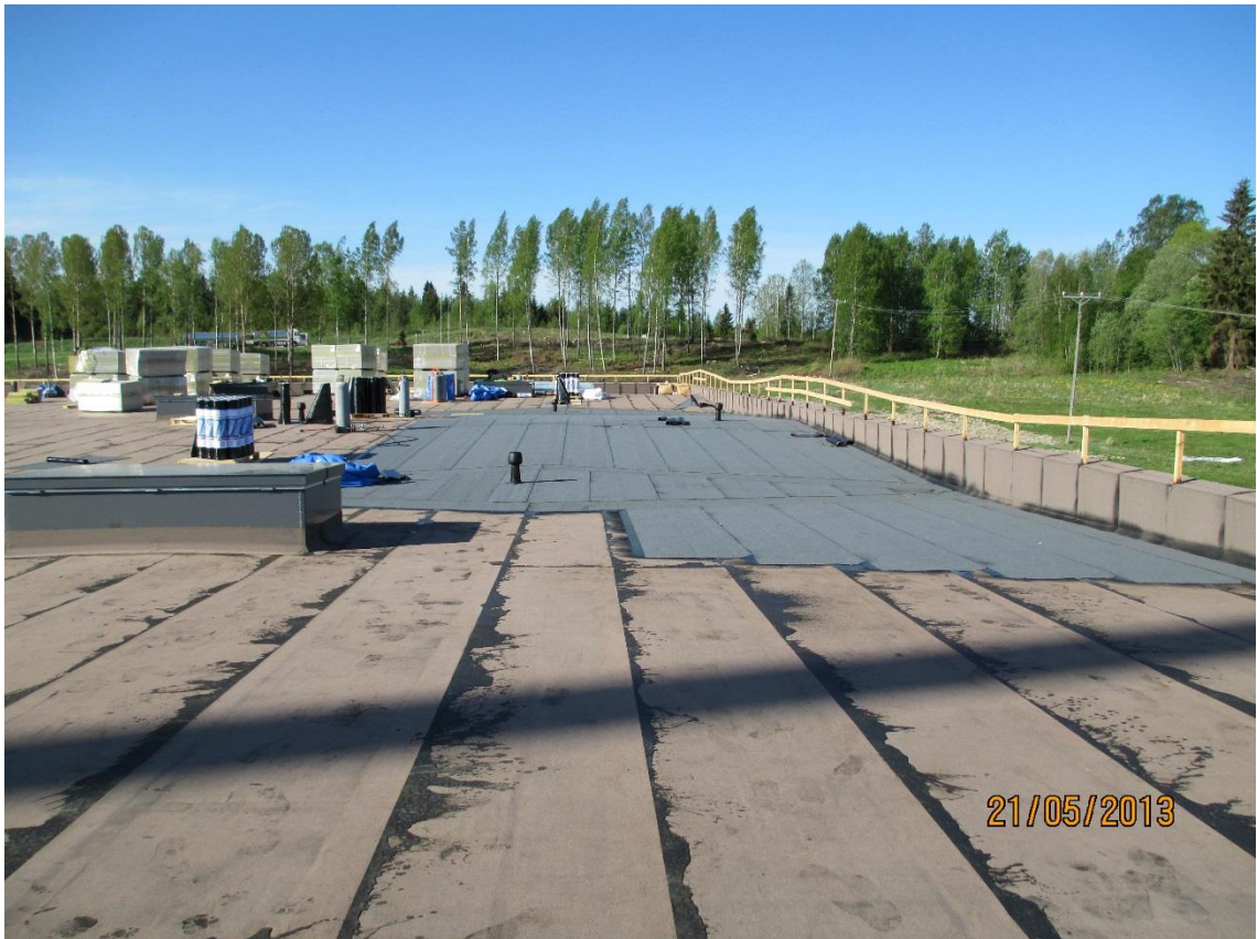
Kuva 3. Bitumikermikattoa
