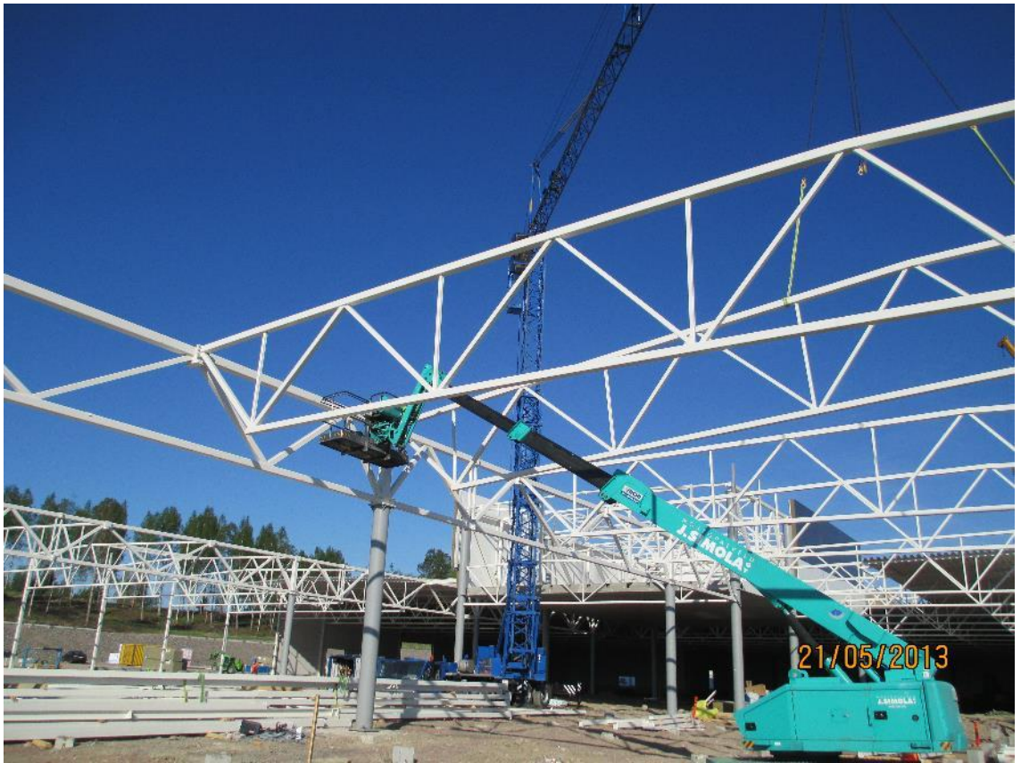
Kuva 1. Teräsrunгон pystytystä
