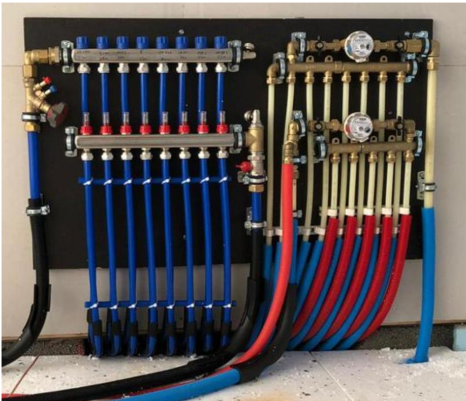
KUVA 5 Tulvarin tekniikkaelementti asennettuna työmaalla.
