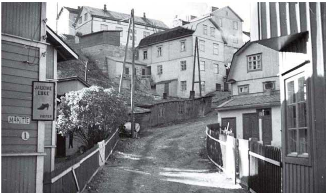
KUVA1. Rinnerakentamista parhaillaan Mäkitiellä (nykyinen Mäkikatu) vuonna 1937 (Vapriikin kuva-arkisto)
