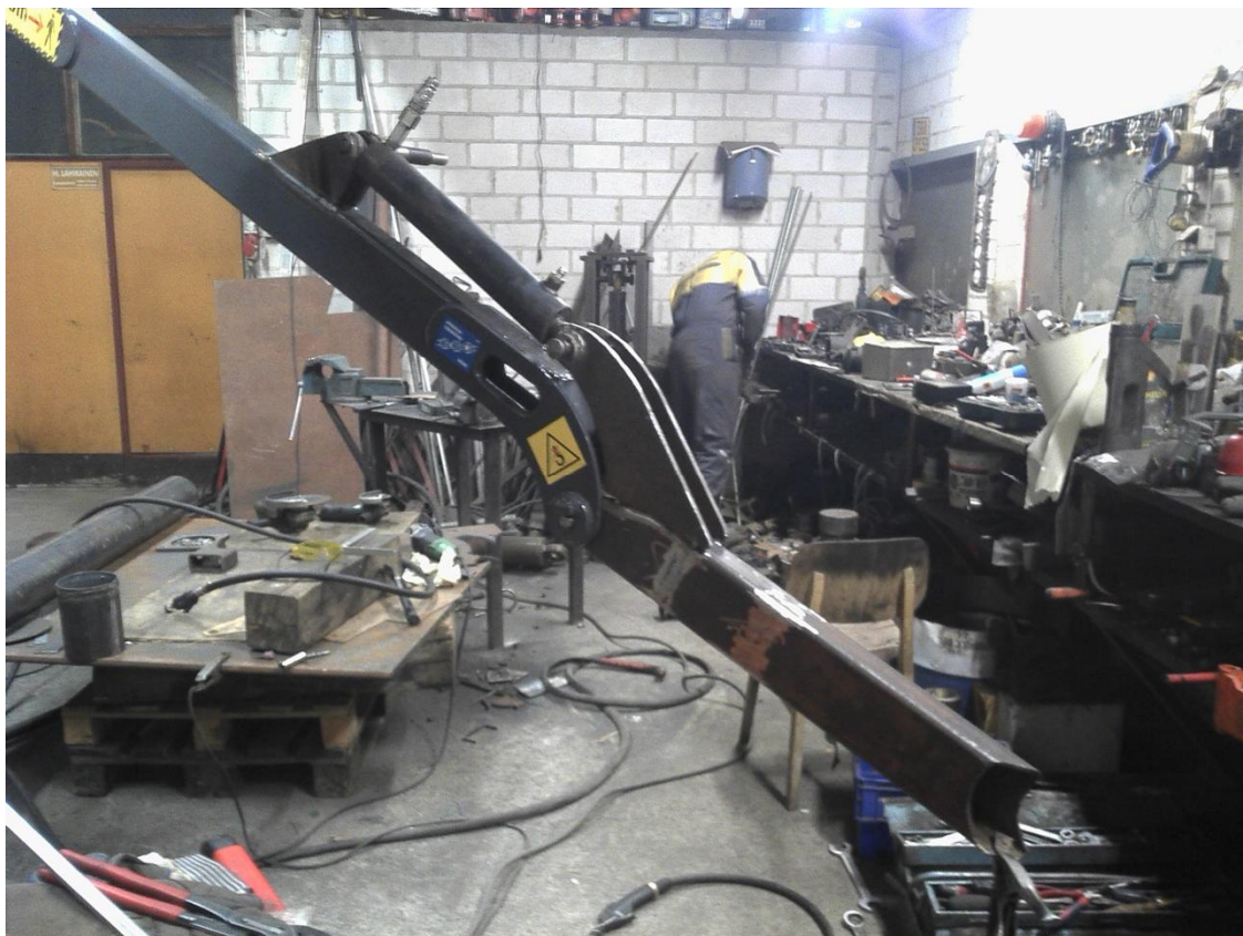
KUVA 9. Pumppupuomin työsylinterin korvakkeiden valmistusvaihe (Jutila 2012.)
