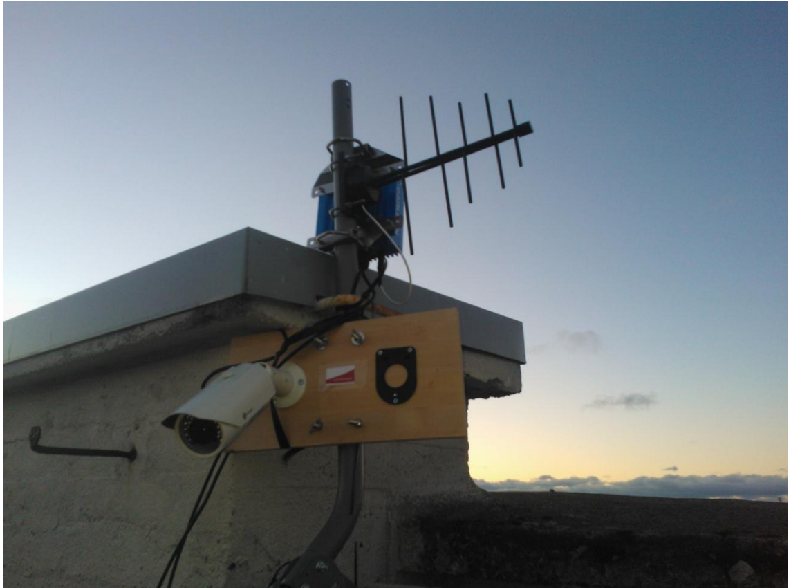
Kuva 31 Lemminkäisenkadun radiolaitteisto sekä valvontakamera asennettuina.
