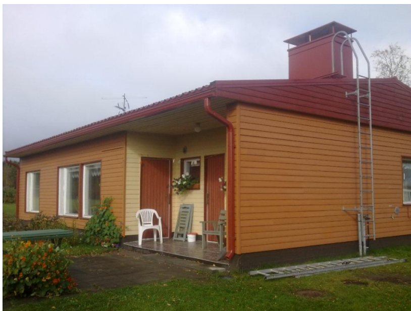
Kuva 7. Saneerauskohte Mieslahdessa, syksy 2013
