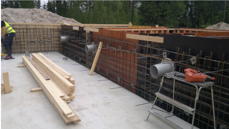
KUVA 8. Raudoitusvälikkeiden asennus ennen tuplausta
