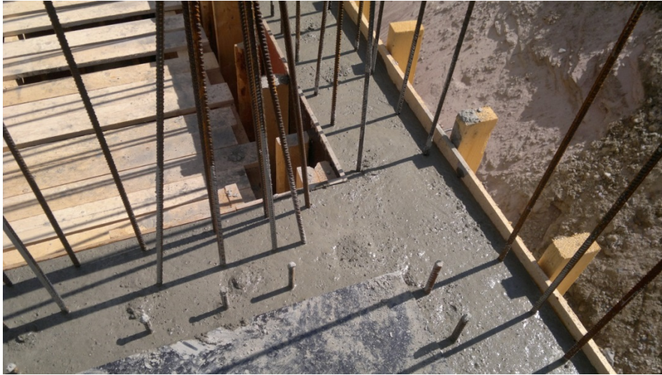
KUVA 10. Valettu ja tiivistetty seinämuotti
