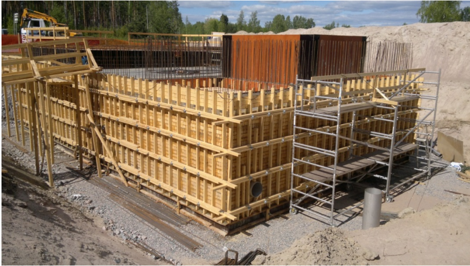
KUVA 4. Muottirakenteita Matinvuoren vedenottamolla
