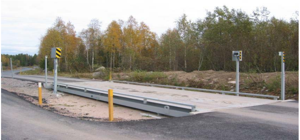
Kuva1. Liikutettava teräsrakenteinen Scalex 1000P -vaakasilta [5]
