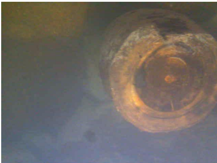
Kuva 28. Kaivon seinämässä parrun pääty
