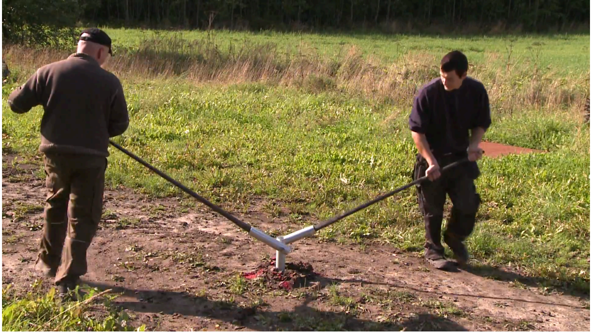
Kuva 15. Porapaalun kiertämistä käsin rautakankea hyödyntämällä (Paalupiste. Kuvakaappaus, [viitattu 08.12.2013].).
