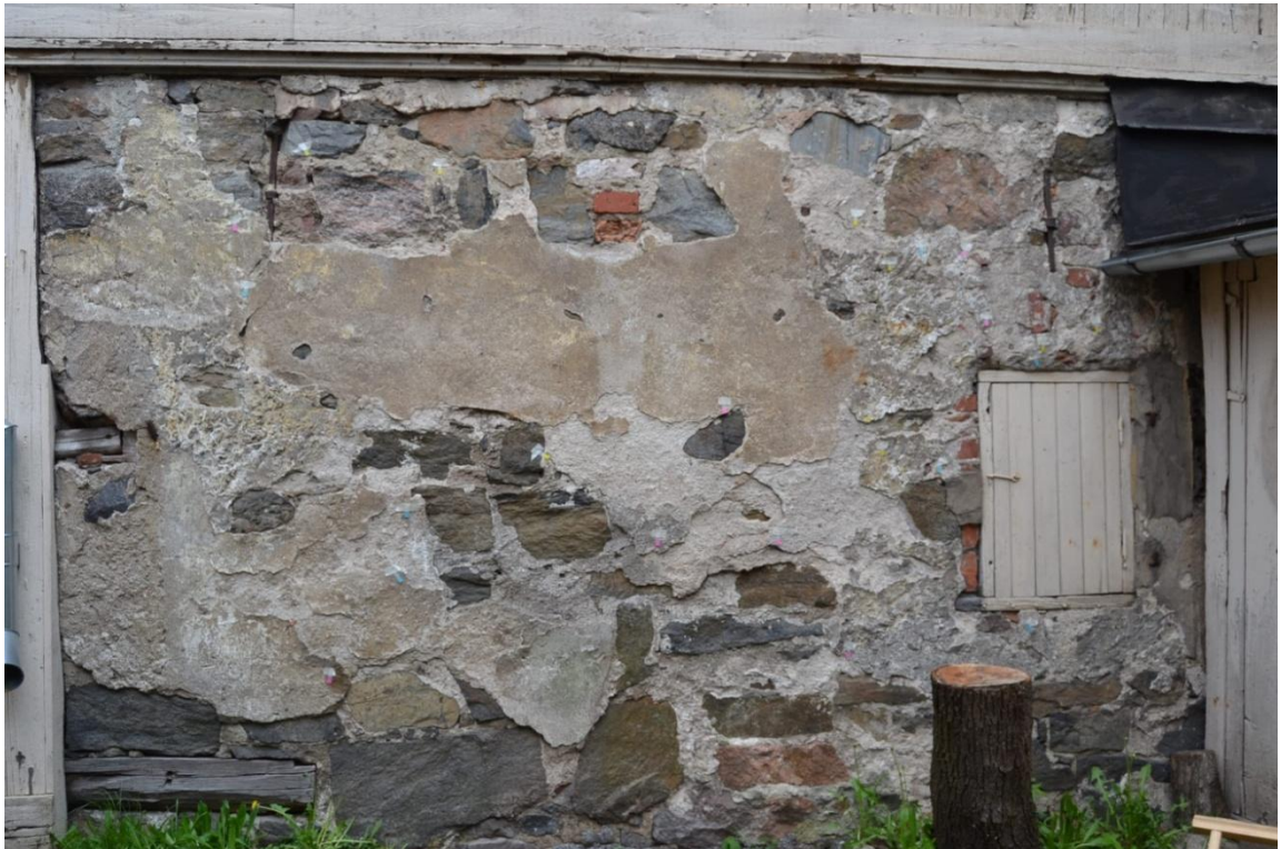
Kuva 3 Iso-Puolalan talon sivurakennuksen kivijalan eteläpääty.
